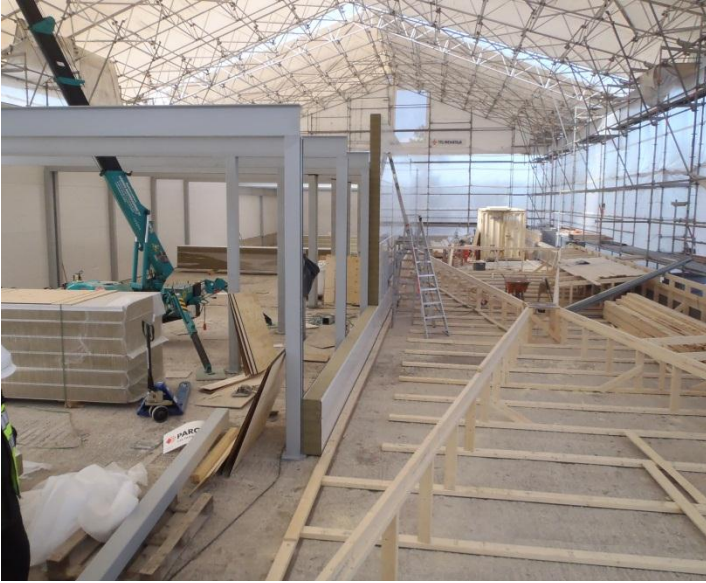
Kuva 33. Vesikattotyöt tehtiin tilavan sääsuojan sisällä.
