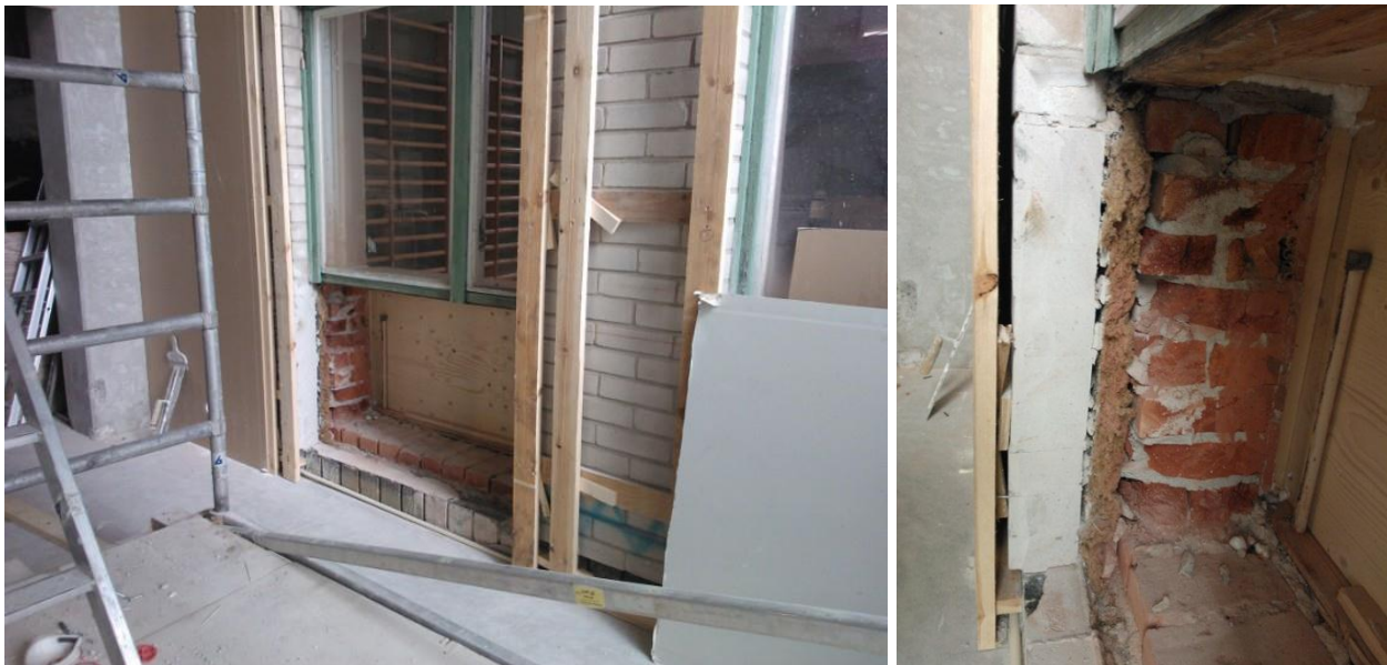
Kuva 25. Sisäseinäksi päällystetty vanha ulkoseinärakenne.
