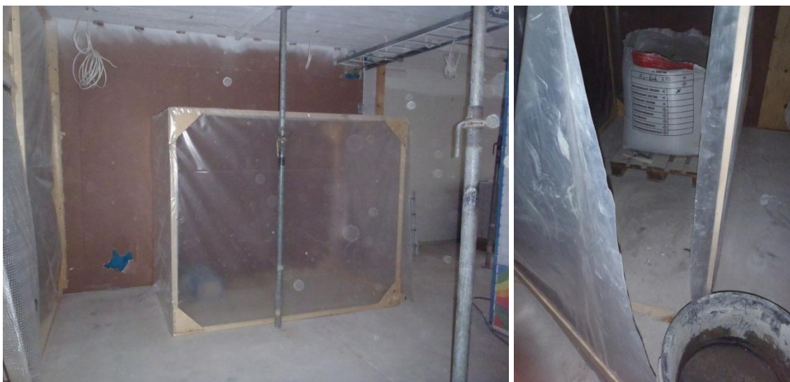
Kuva 32. Betonin sekoitustyöt tehtiin erikseen rakennetuissa suojissa. Pölynleviämisen estävä levyseinä oli myös äänieristetty.
