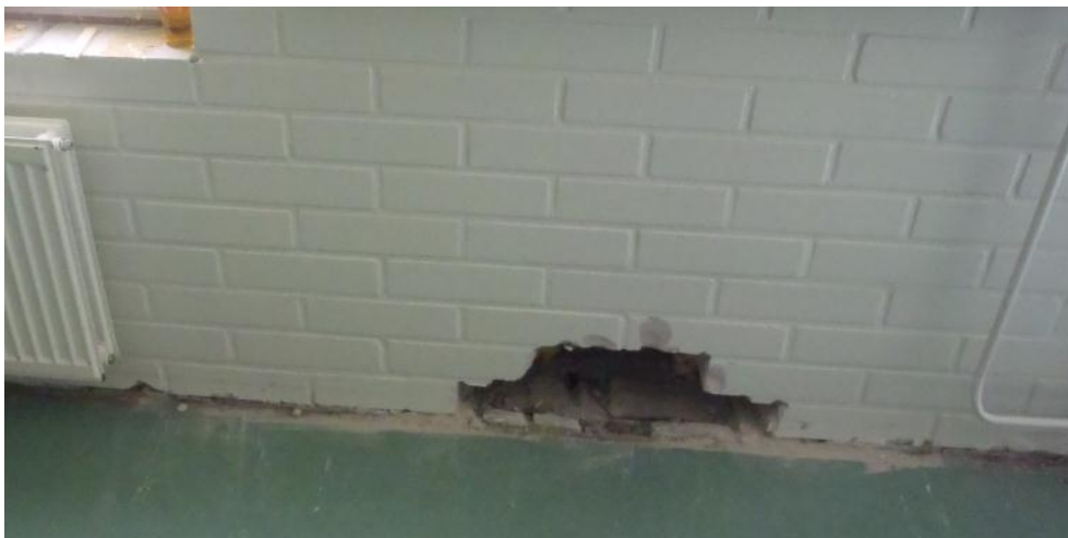
Kuva 9. Esimerkki rakenneavauksesta. Rakenneavaus voi olla myös esimerkiksi kosteusmittausta, materiaalinäytettä tai endoskopointia varten tehty porausreikä. Joissakin tapauksissa riittää pelkkä pintamateriaalin irroittaminen.
