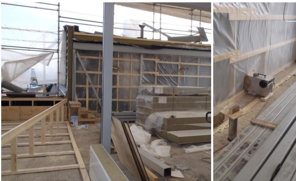
Kuva 13. Vesikatto korjattiin tilavassa sääsuojassa ja pölyn leviäminen aiemmin valmistuneeseen ilmanvaihtokonehuoneeseen oli estetty.
