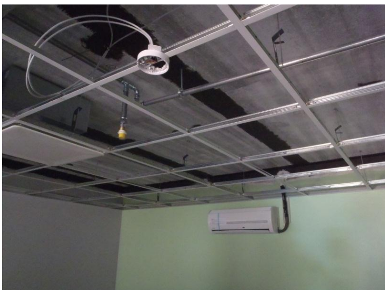
Kuva 44. Tiivistettyjä läpivientejä
