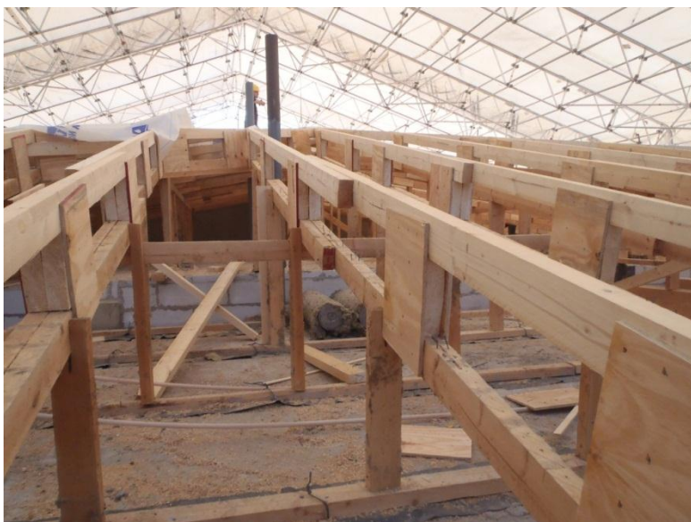
Kuva 45. Vesikattoa korotettiin ja räystästä pidennettiin sääsuojauksessa.
