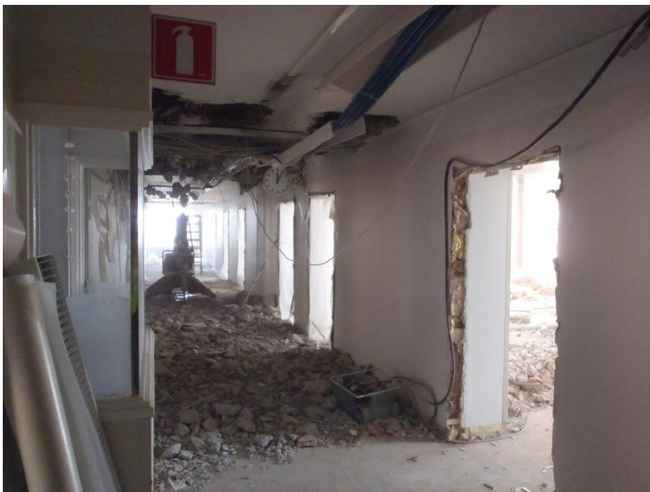
Kuva 30. Alakaton betonilaatan purkutyössä hyödynnettiin purkurobottia.
