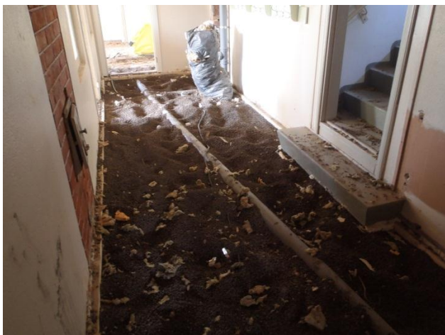
Kuva 37. Käytävän alapohjarakenne oli uusittu edellisenä kesänä. Syynä oli ollut putkivuoto. Peruskorjauksen yhteydessä myös viereisien tilojen lattiarakenteet uusittiin.
