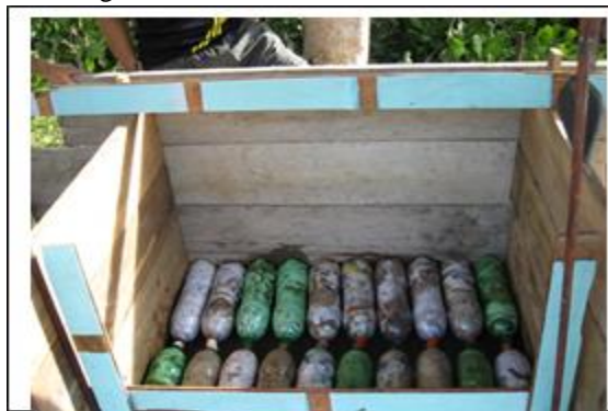
Figura 20. Formaleta de una silla con ladrillos ecológicos
