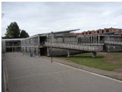
Imagen 16. Visual exterior del CED Don Bosco V, planta abierta.
