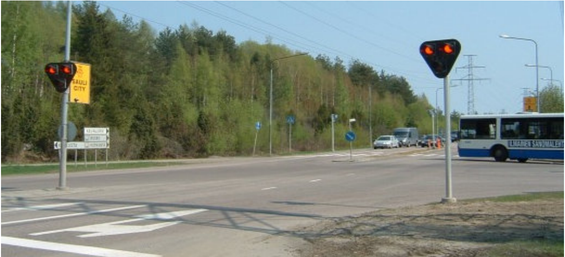
Kuva 102. Jokerivalojen toimintaperiaate Hepolamminkatu- ja Tieteenkadun liittymässä ja alakuvassa Jokeri-valot toiminnassa (Tampereen kaupunki 2010).
