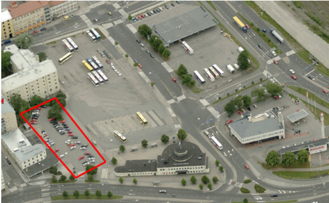
Kuva 131. Turun linja-autoaseman liityntäpysäköintialue (Turun kaupunki/YKV/suunnittelutoimisto 2010).
