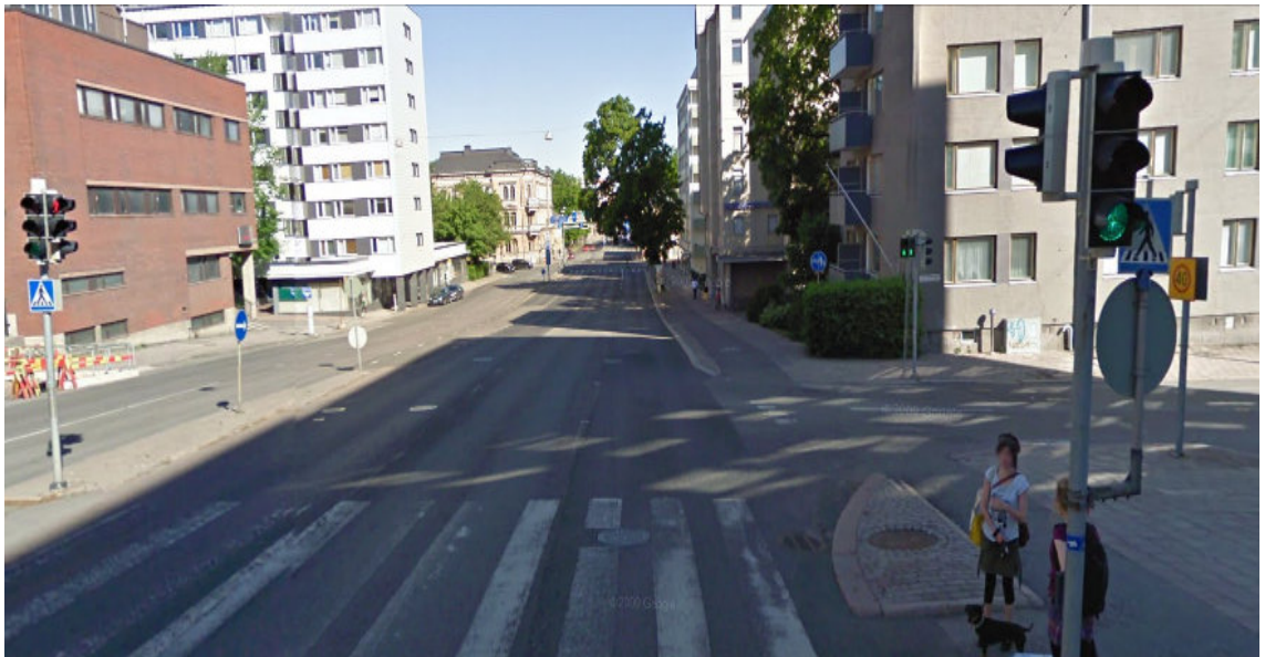
Kuva 148. Uusittavat liikennevalot: Uudenmaankadun ja Vähä-Hämeenkadun (604) liittymä (Google Map 2010).
