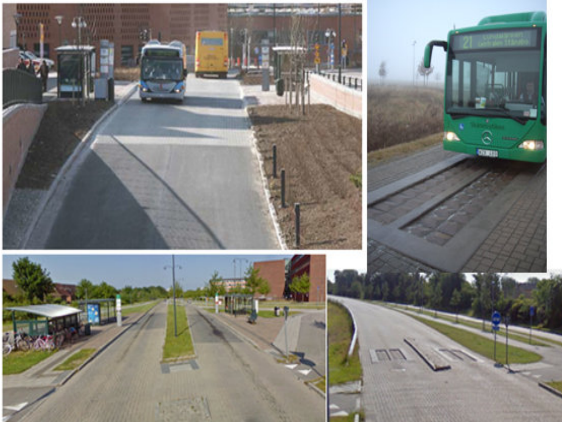
Kuva 64. Lundalänken, korkean tason liikenneteknisiä ratkaisuja bussiliikenteelle: yläkuvat: Universitetsjukhusetin pysäkkipari ja linja 21 ylittämässä hidastetta; vasen ja oikea kuva: pysäkkiratkaisut ja kevytliikenteen ylitys hidasteiden jälkeen Sölvegatanilta (Lunds kommun 2008).
