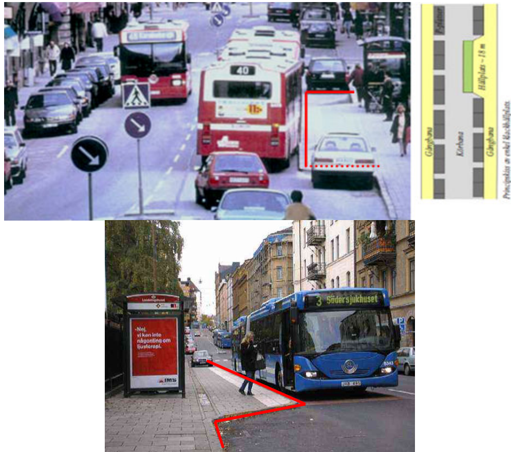
Kuva 108. Saarekepysäkit Tukholmassa (Vägverket 2003; Sedin S. 2008)
