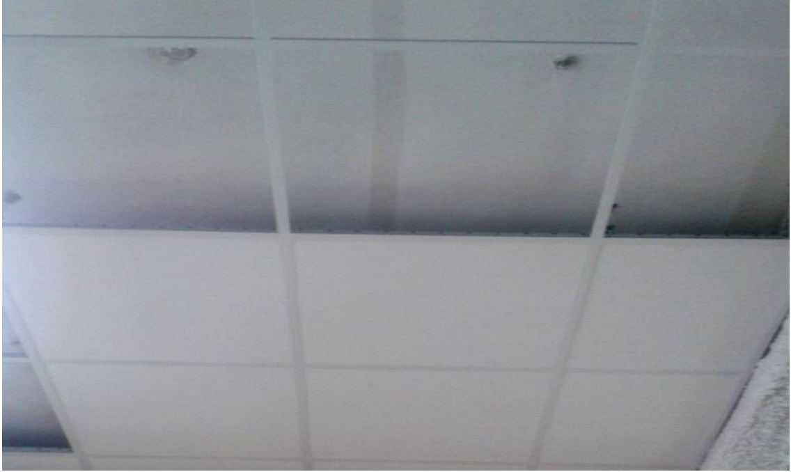
Anexo 8. Acondicionamiento Acústico con cámara de aire
