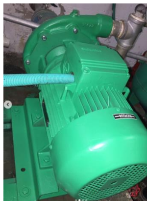
Figura 14. Cambio de pintura bomba. ((Propiedad de los autores Ingecol S.A.S), 2018)
