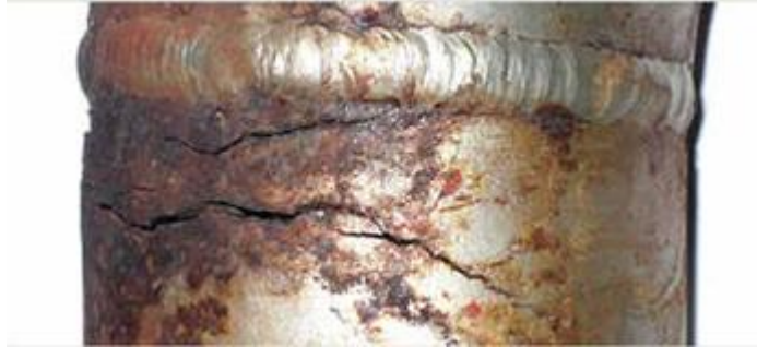
Ilustración 5. Corrosión bajo tensión
