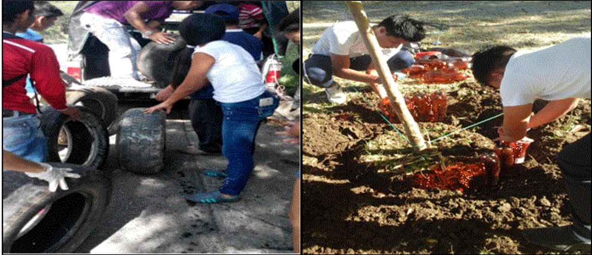
Figura 8. Reciclando y preparando materiales para la adecuación del espacio recreativo
