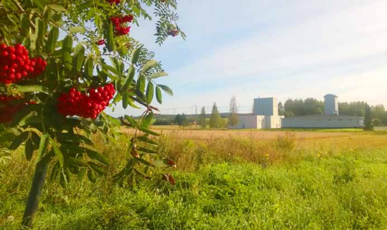
Kurikan jätevedenpuhdistamo. (Juuti)
