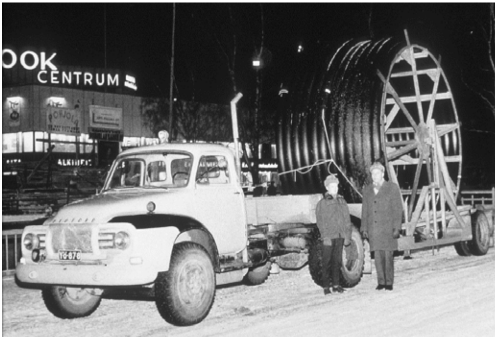
Kelalle kierretty 6 tuuman muoviputki öisellä matkalla Oulussa v. 1961. (Kalevan arkisto)
