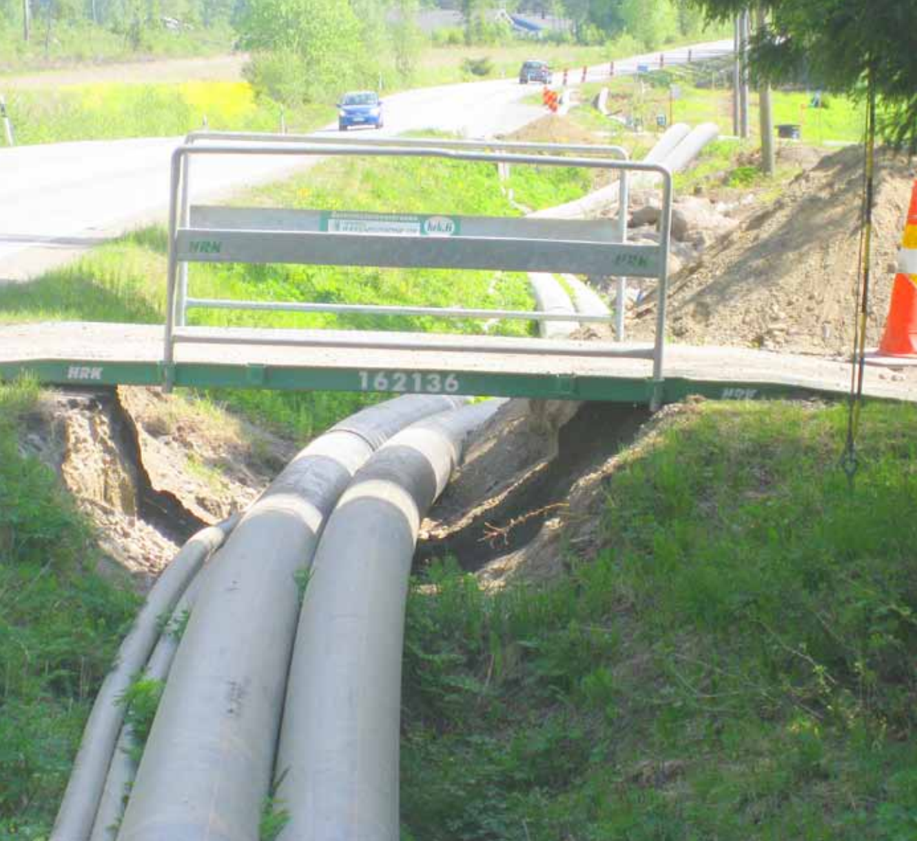
Saarenmaantien viemäri. (Pietilä 2010)
