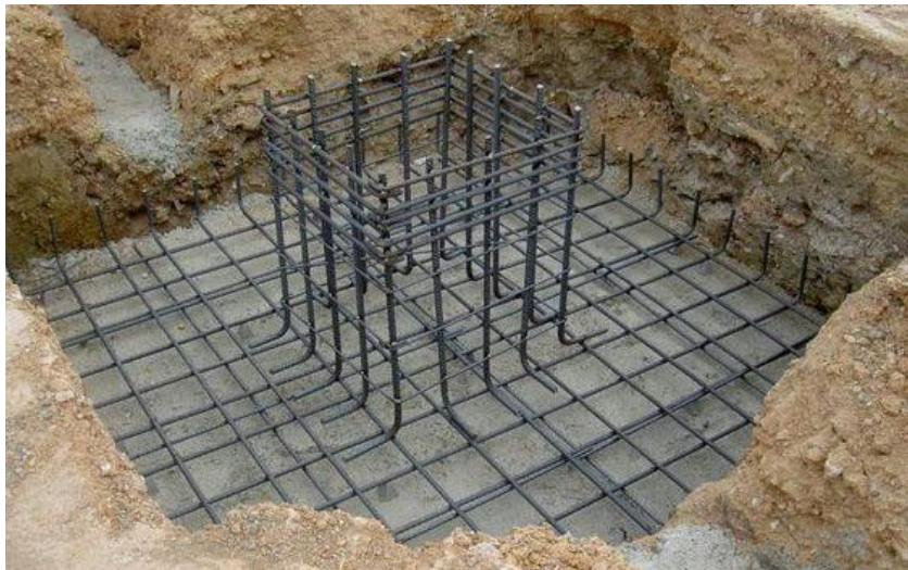
Figura N° 1: Zapata aislada.
