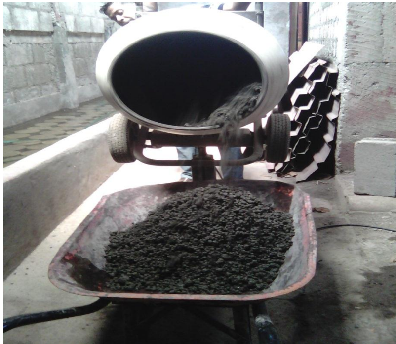
Figura 5.11 Muestra el mezclado del concreto permeable
