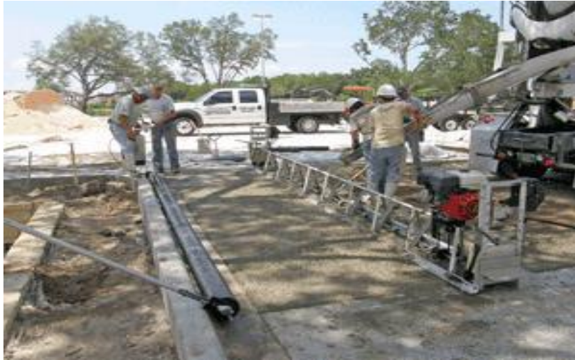
Figura 2. 21 Enrasado del concreto permeable mediante el uso de una enrasadora vibratoria de marco con sección tipo "A"
