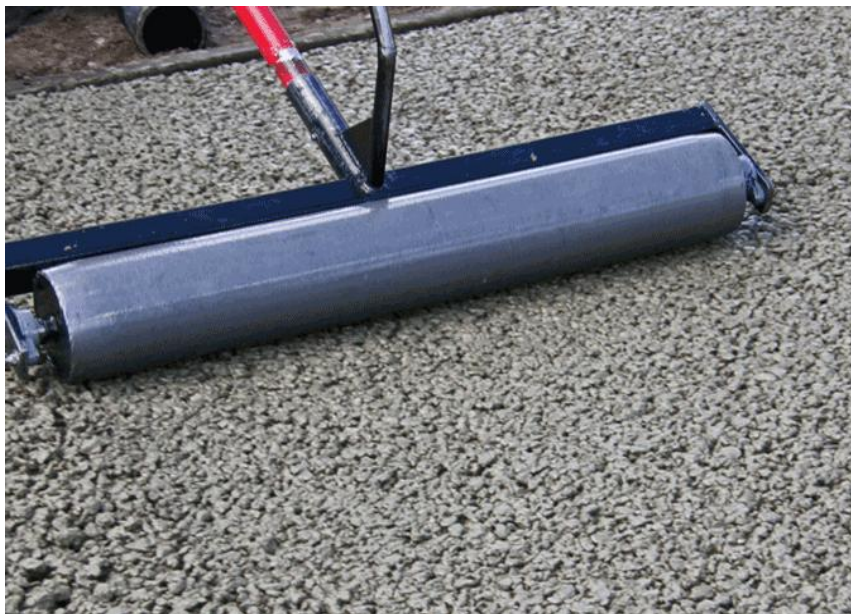
Figura 2. 23 Rodillo pequeño usado para compactar un área pavimentada pequeña
