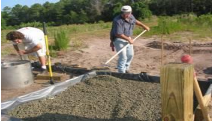
Figura 2.18 Rastrillado del concreto permeable a una elevación aproximada
