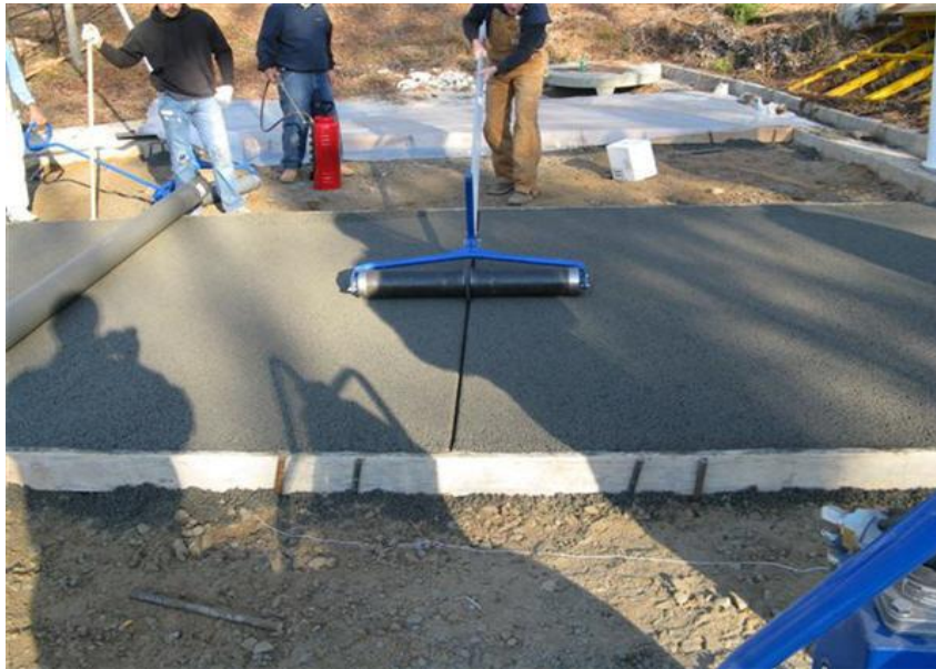
Figura 2. 20 Encofrado de madera sujeta a base de clavijas
