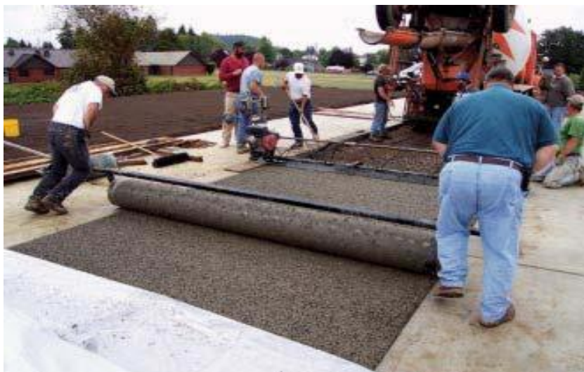
Figura 2. 22 Compactación del concreto permeable mediante el uso de un rodillo
