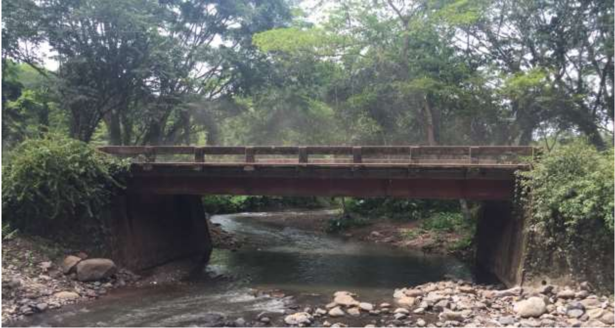
Figura 7: Puente la Zomopera visto desde aguas abajo
