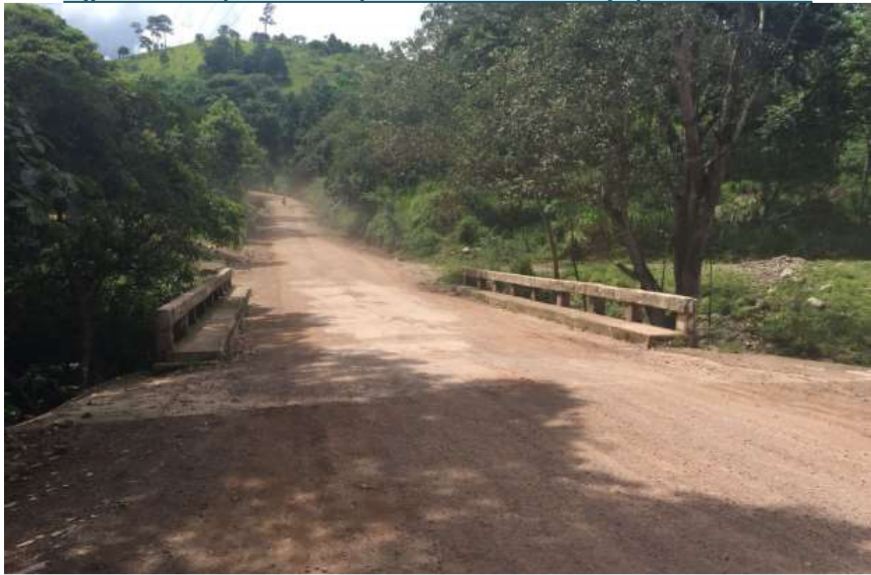
Figura 6: Vista parcial de superficie de rodamiento y aproche de salida
