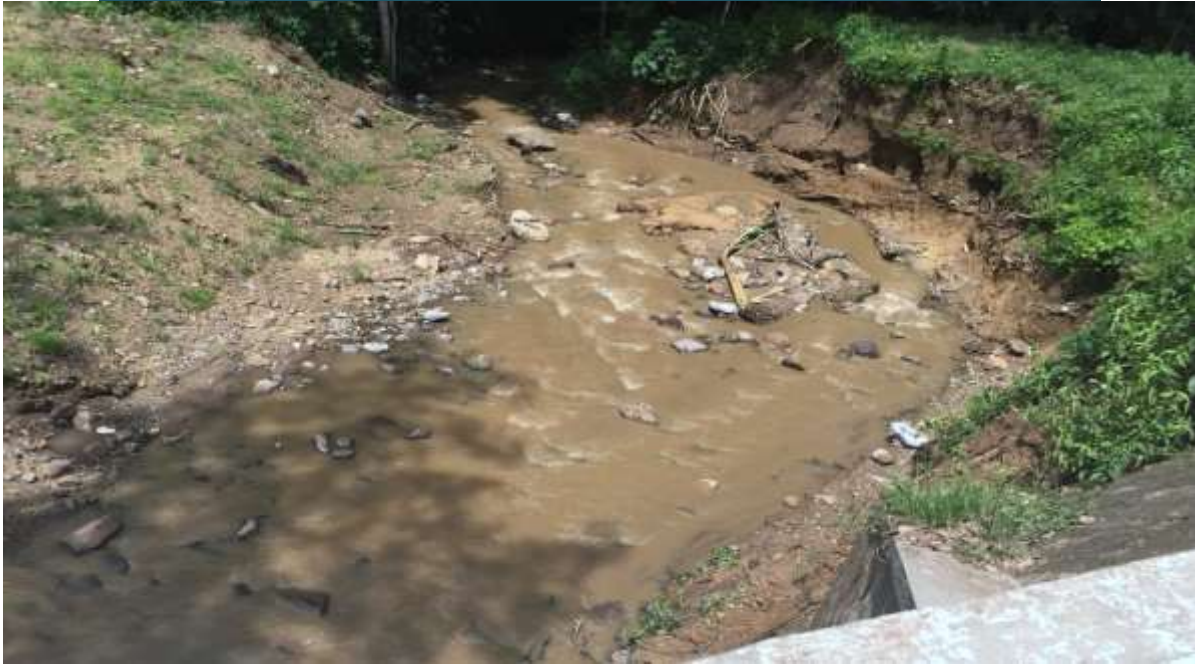
Figura 3: Río la Zomopera aguas arriba del puente la Zomopera
