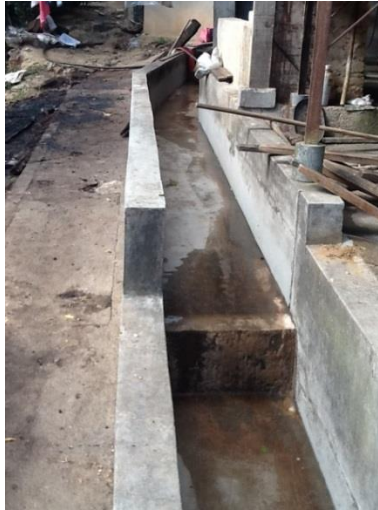
Fotografía 4.- Preparación del canal para el lavado del café
