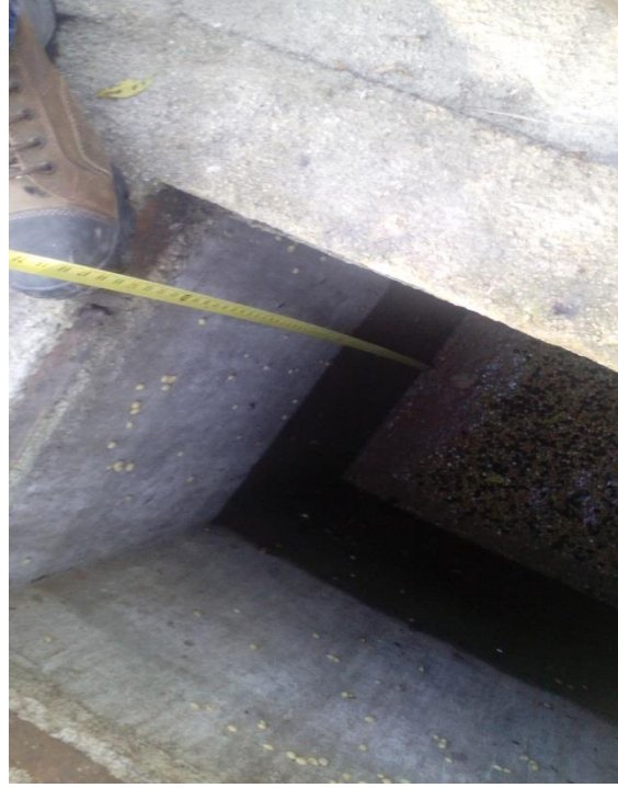
Fotos H.5. Pila séptica para almacenamiento de Aguas residuales generadas en el lavado del café.
