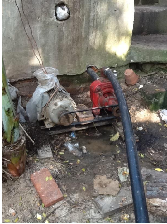
Fotos H.7. Bomba para transporte de agua residual a zanja natural cuando el tanque séptico rebasa su capacidad.
