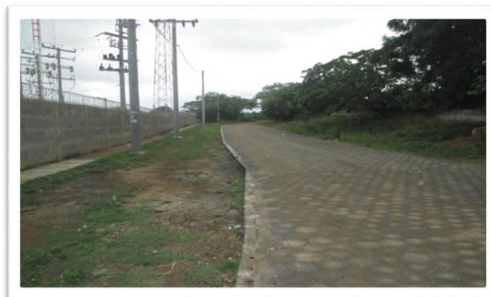
Parte actualmente adoquinada del tramo en estudio. (50 m)
