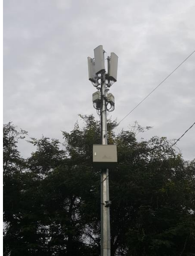
Figura 1- 5 Arquitectura micro celda.
