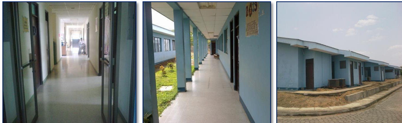
Imágenes 63, 64, 65 (de izquierda a derecha): Pasillo Interno, Pasillo Externo techado y Andenes.
