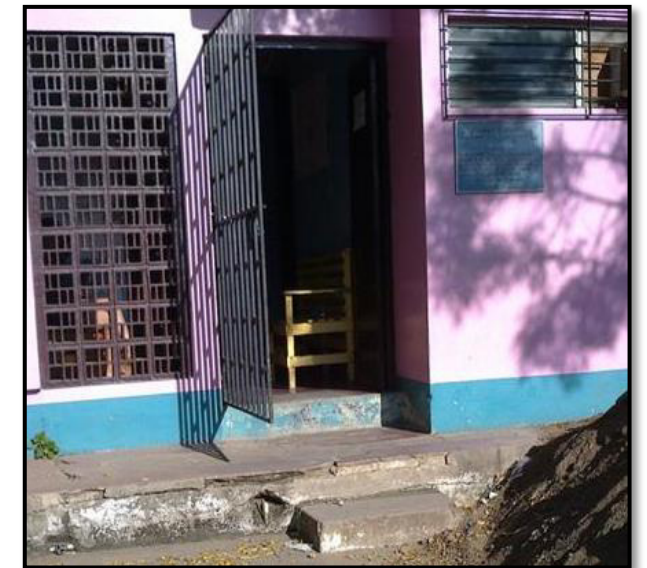
Imagen 19. Acceso a Sala de Emergencia del CSGGL. Fuente: Propia.
