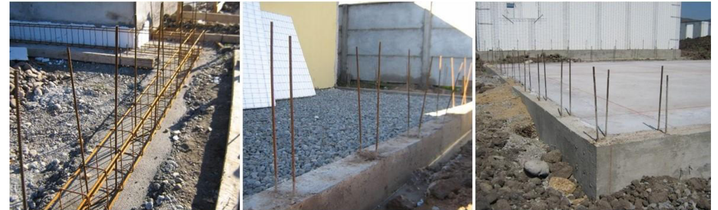
Ilustración 113: Proceso de la ejecución en obra de los cimientos.
