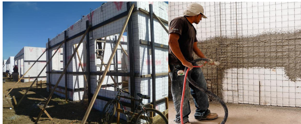
Ilustración 116: Alineación de Paredes http://www.hopsa.com.ni/photos/protecto2012_05.jpg
