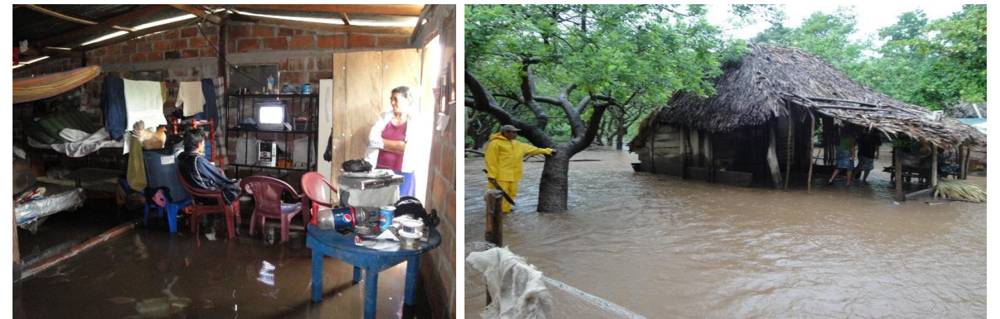
Ilustración 71: Viviendas inundadas en el municipio de Telica
