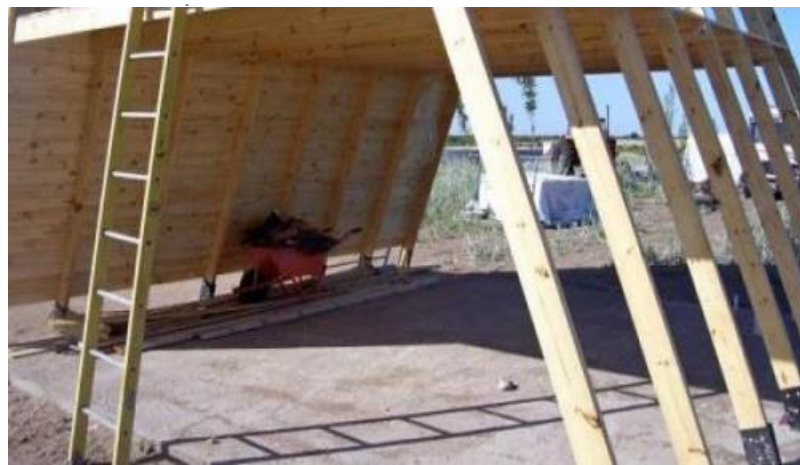
Ilustración 97: Ejemplo de arranque inclinado con pasadores metálicos incrustados.
