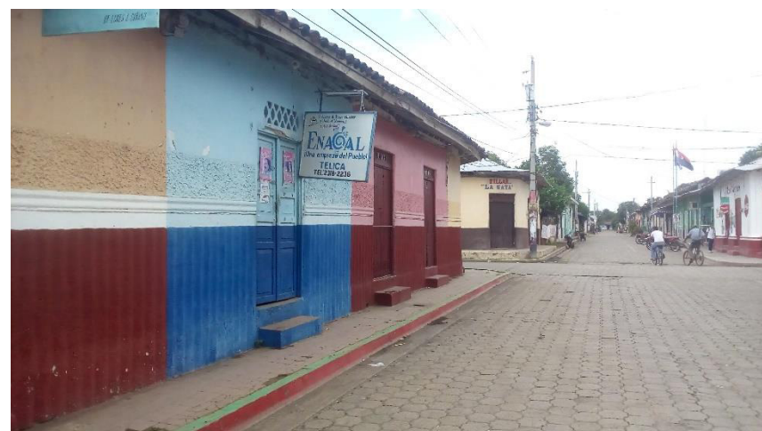
Ilustración 81: Instalaciones administrativas de ENACAL en Telica Fuente: Propia
