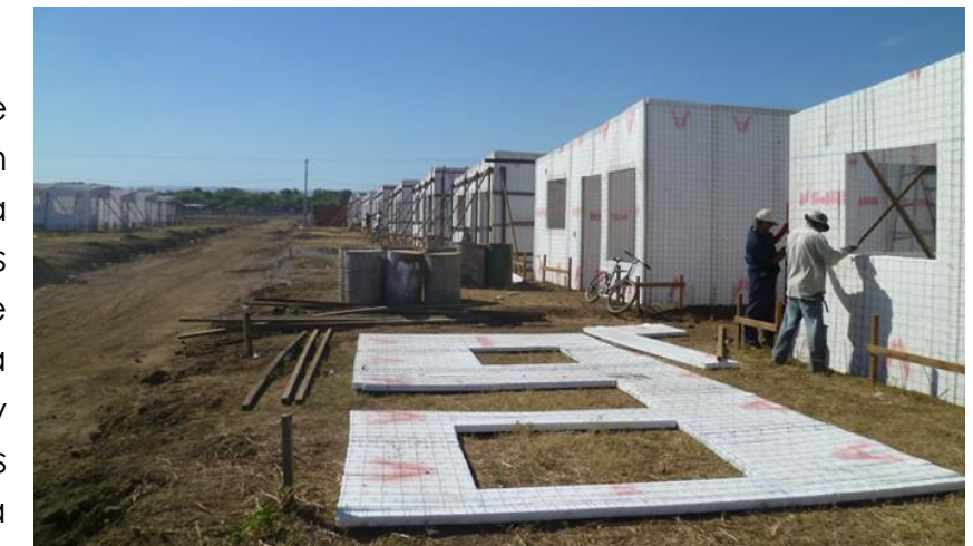
Ilustración 114: Levantamiento de paredes VIVIENDAS DE VALLES DE SANDINO
