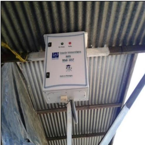
800 metros al norte, en la Finca La Purísima. En la **Fig.4.21**, se muestra la caja metálica NEMA 50x40cm, IP66 dentro de la caja esta la UDP, la fuente de alimentación y las baterías de respaldo. La caja se instaló a 3m de altura, con el fin de prevenir daños por lluvia y polvos que afecten el funcionamiento de los circuitos.
