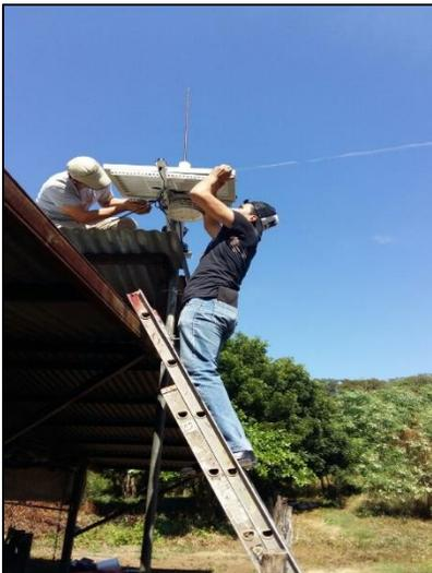
El sensor DHT22 se instala a 6 metros de altura, para medir la temperatura y la humedad relativa del aire. En la **fig. 4.3**, se muestra la instalación de los sensores
