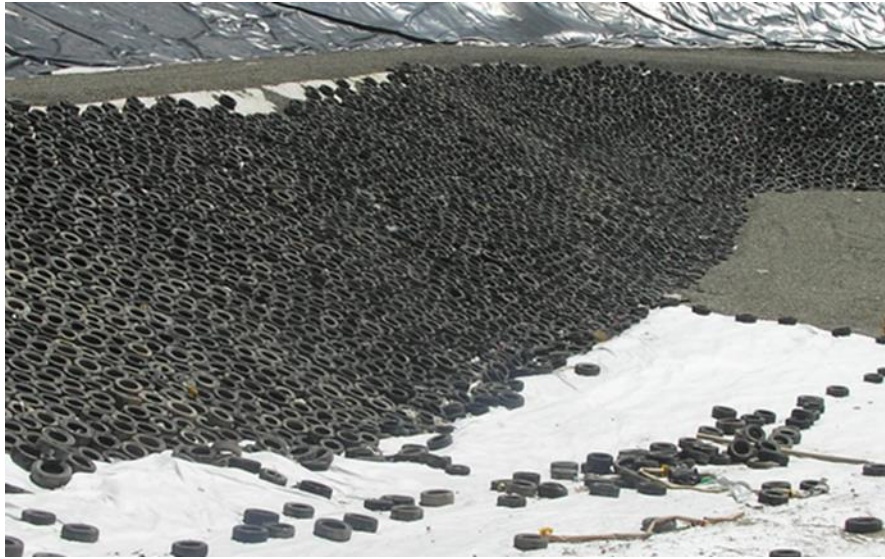
Figura 13.- Material de drenaje.
