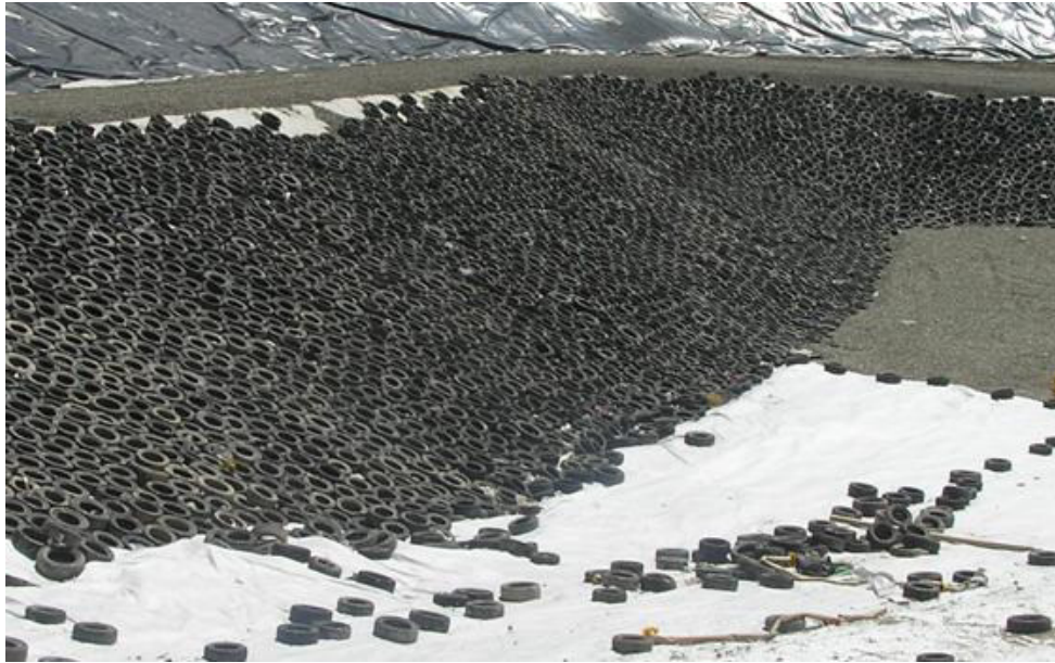
Figura 15.- Material de drenaje.
