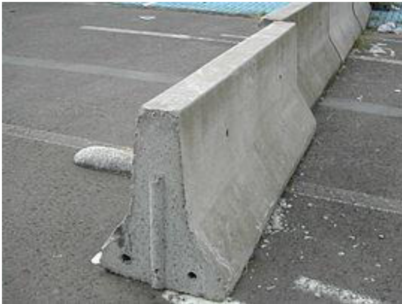
Figura 4.- Barreras New Jersey.
