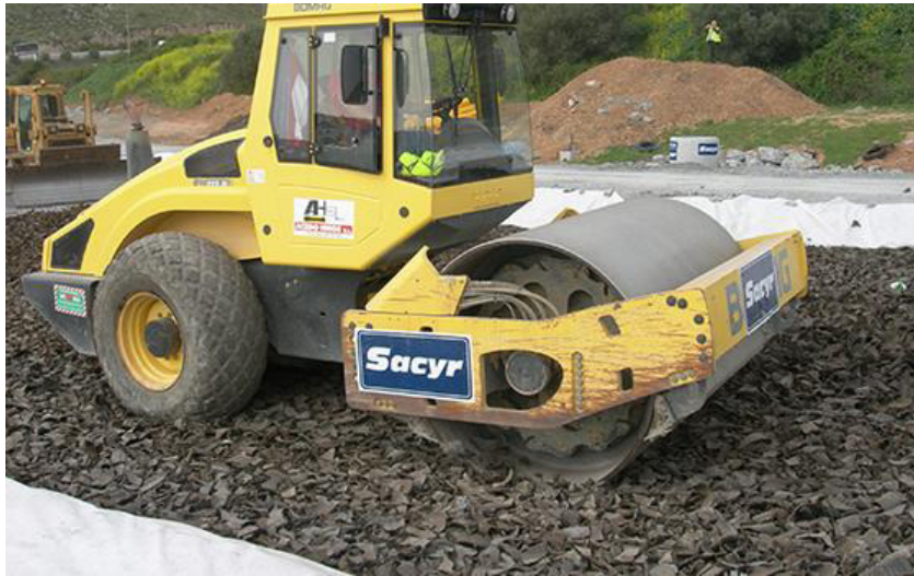
Figura 9.- relleno ligero de terraplenes.
