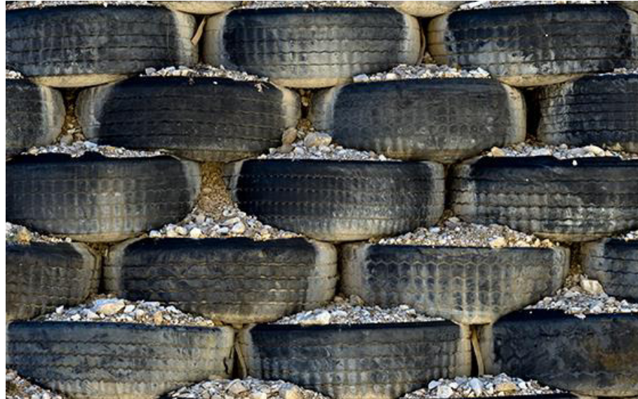
Figura 8.- Construcción de taludes.
