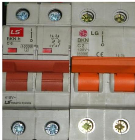
Figura :Breaker automático.
