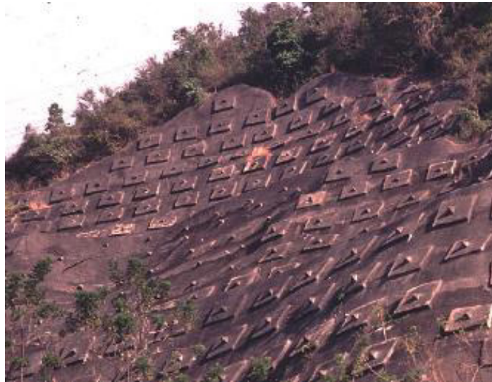
Ilustración 40 Mecanismo básico de Anclajes
