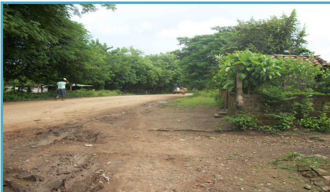
Panorámica de la vía
