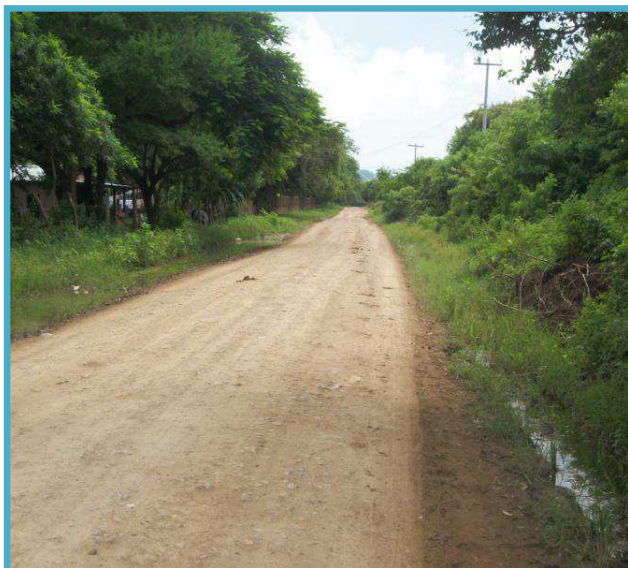
Panorámica de la vía
