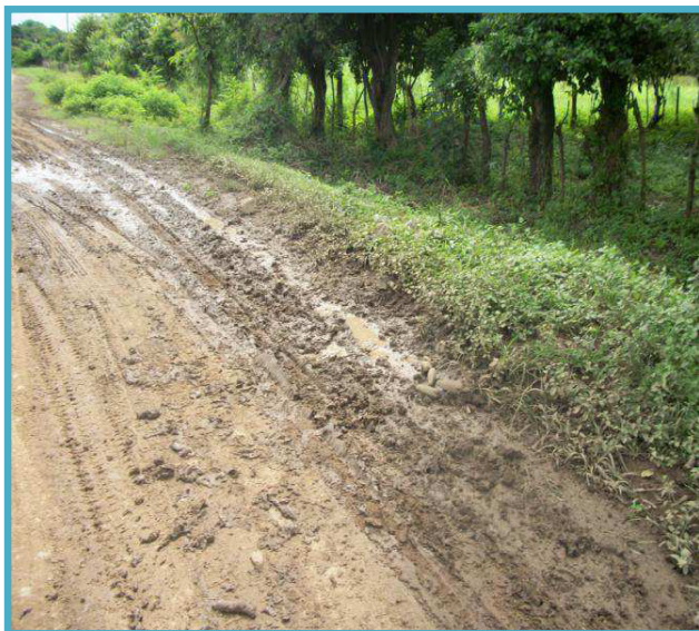
Panorámica de la vía
