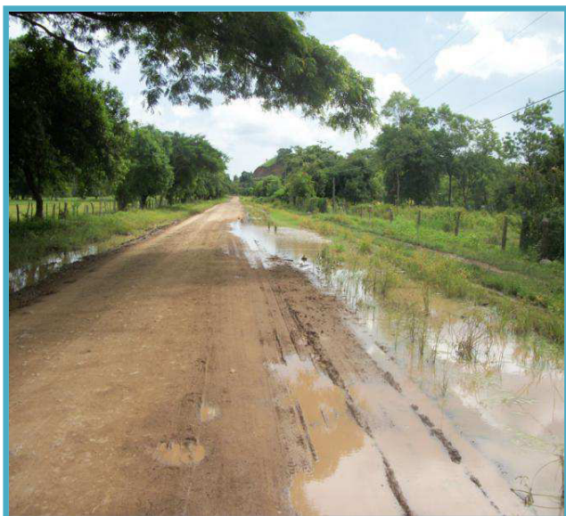
Zona inundada de la vía
