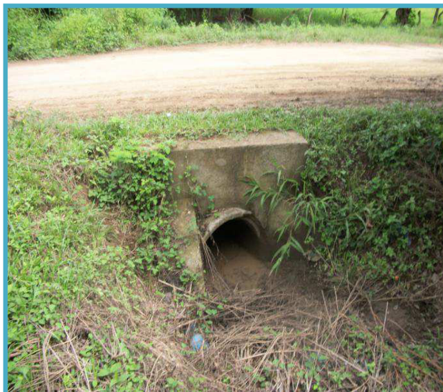
Obra de drenaje existente
