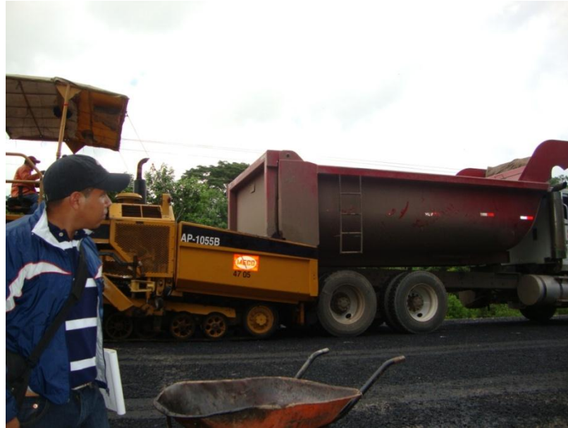
Foto 7: Muestreo de Mezcla suelta.
