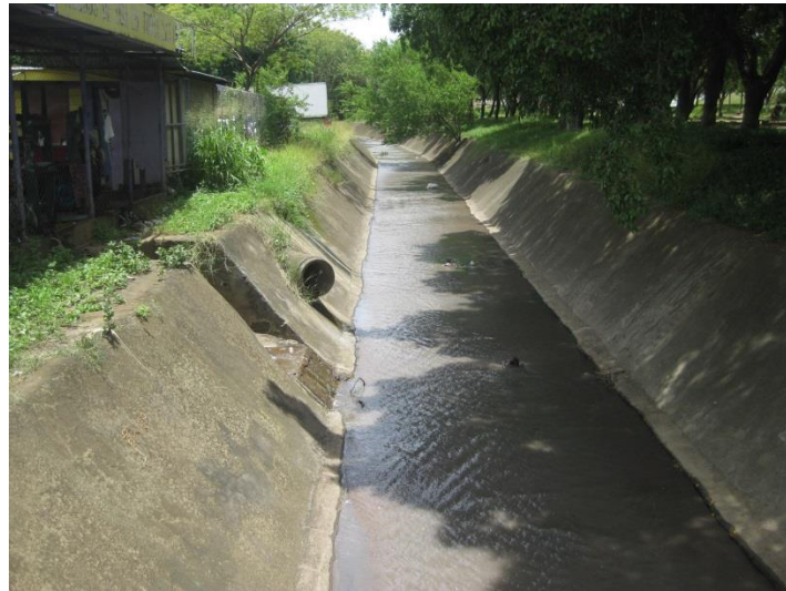
Ilustración 7 Cauce ubicado en el costado Este del Parque Fuente: Autores
