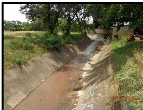
Ilustración 13. Cauce de drenaje pluvial ubicado al este del parque. Fuente: Autores
