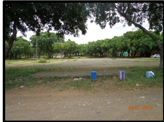
Ilustración 21. Vista panorámica de la plaza de acceso norte y su estado actual.
