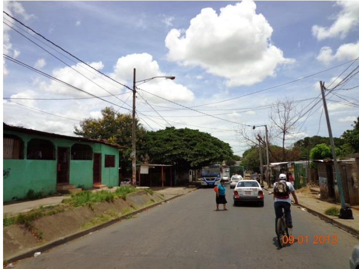
Ilustración 8 Calle Costado Sur del Sitio, líneas de media tensión. Fuente: Autores
