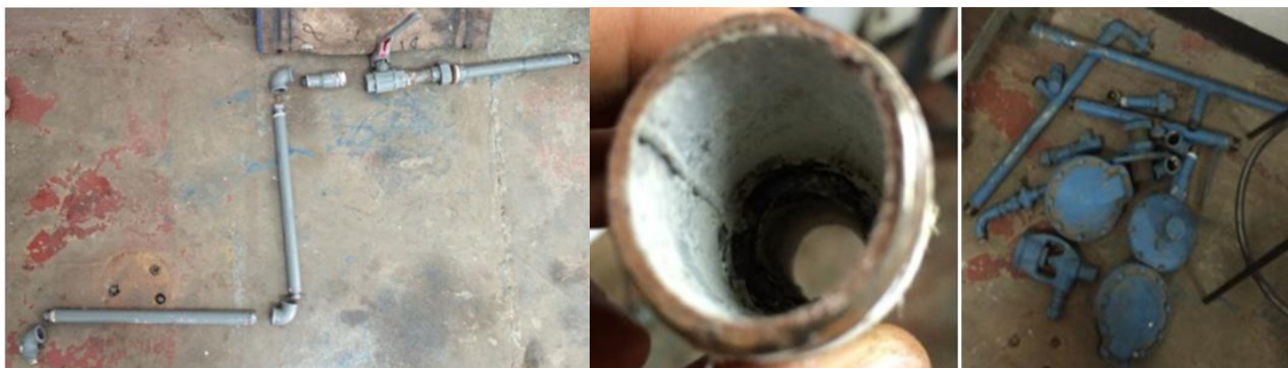
Figura 11. Desarme y limpieza del sistema de suministro de gas.
