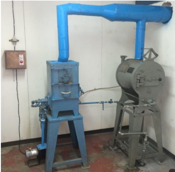
Figura 26. Instalación de los hornos terminada.
