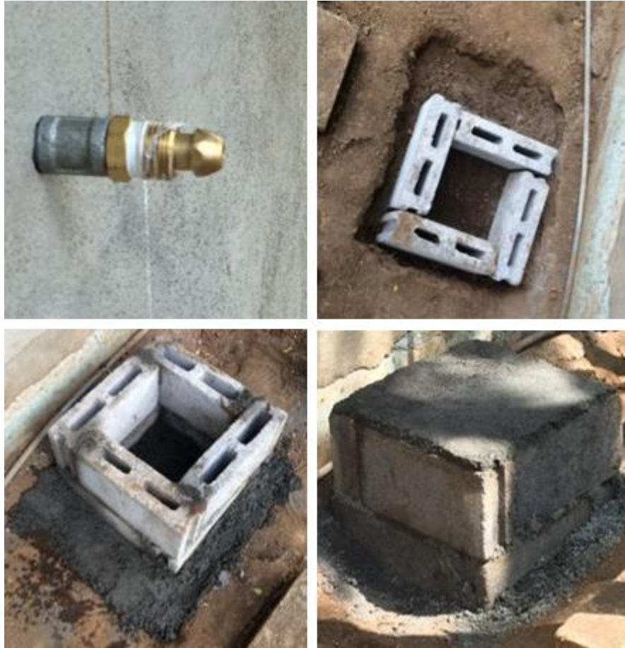
Figura 21 Construcción de base de concreto para tanque de gas propano.
