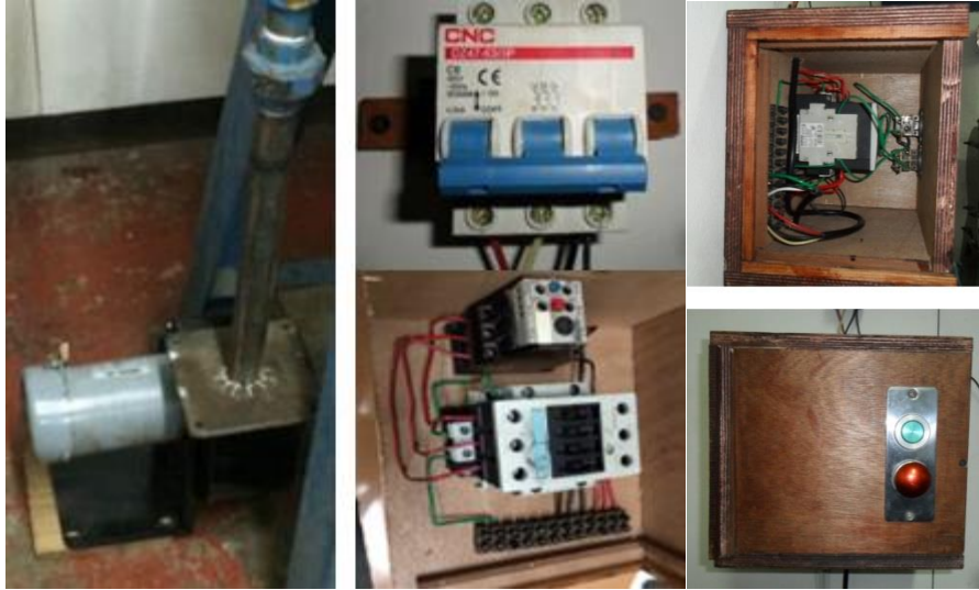
Figura 24. Izquierda, Turbo ya instalado. Centro, breaker trifásico (arriba) y sistema de arranque y paro (abajo). Derecha vista frontal y lateral de la caja ya cerrada
