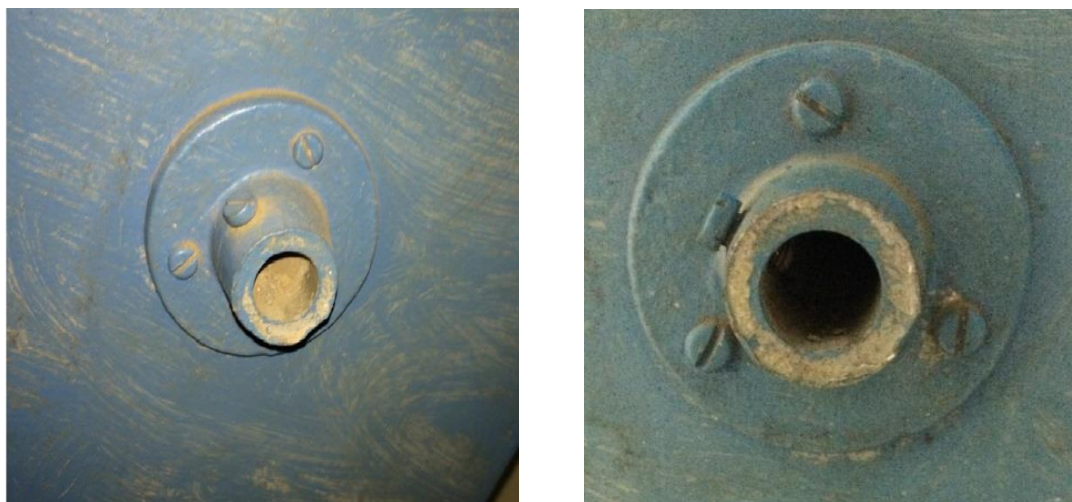
Figura 36. Base con tornillo de sujeción para el antiguo instrumento de medición (el agujero llega hasta la recámara inferior).
