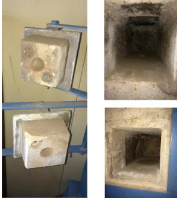
Figura 17 Izquierda, puertas de las recamaras; derecha, recámara superior e inferior, respectivamente.
