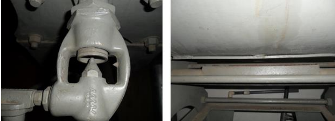
Figura 28. Izquierda, Inyector y entrada del quemador. Derecha, salida de la flauta.
