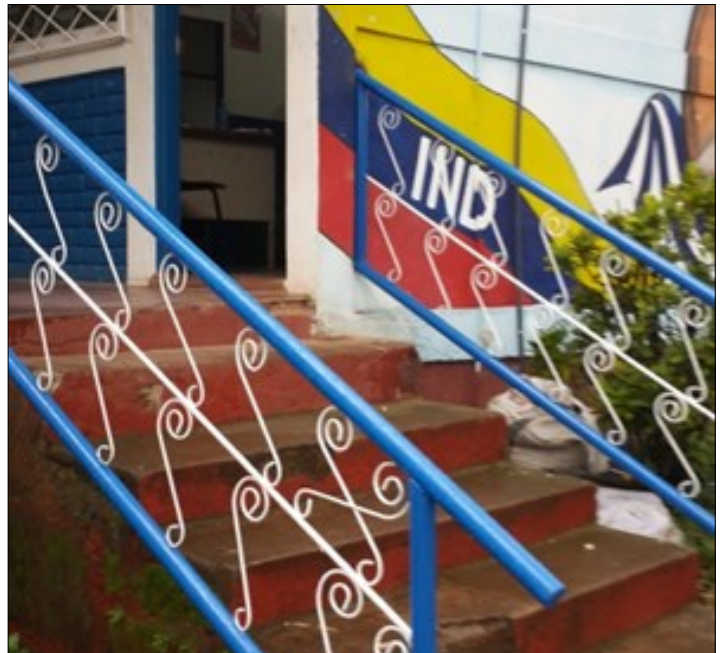
Mantenimiento en pasa manos/ Fuente:Elaboración propia.
