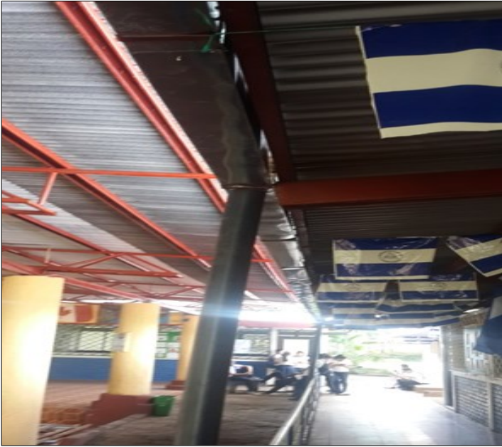
Instalación de bajante /Fuente:Elaboración propia.
