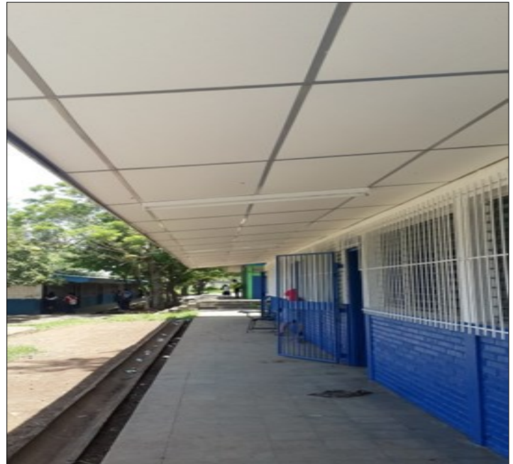
Intalación de luminarias/Fuente:Elaboración propia.
