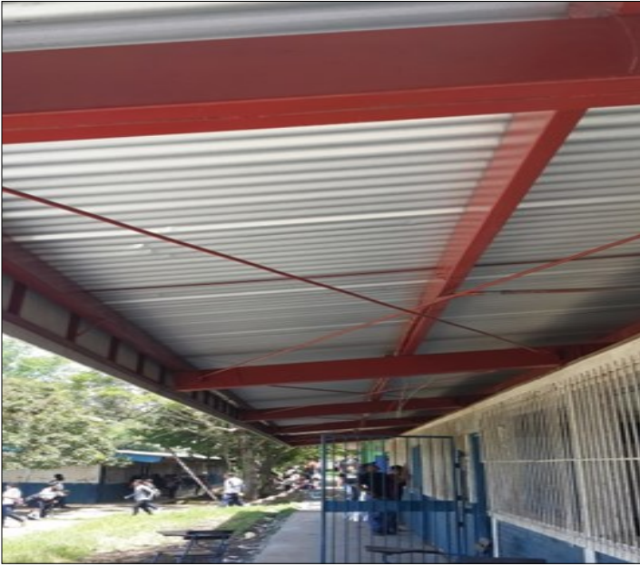
Cambio de cubierta techo /Fuente:Elaboración propia.
