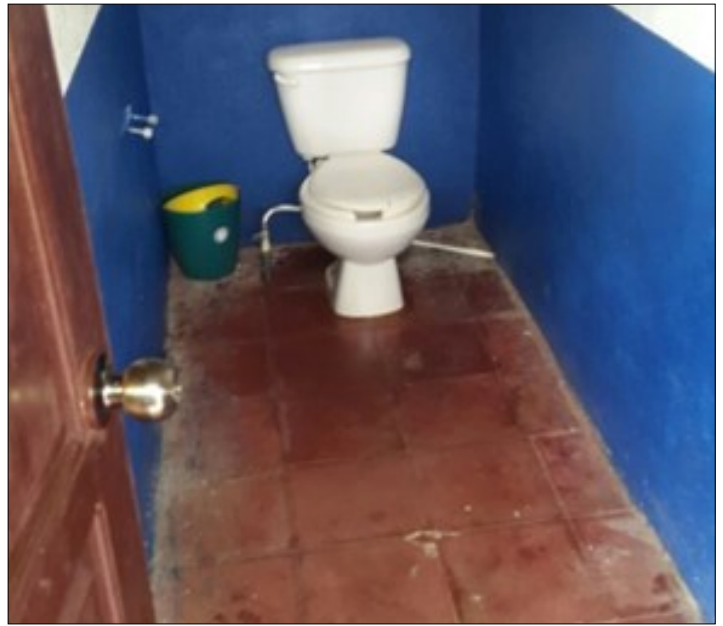
Aplicación de pintura/Fuente:Elaboración propia.
