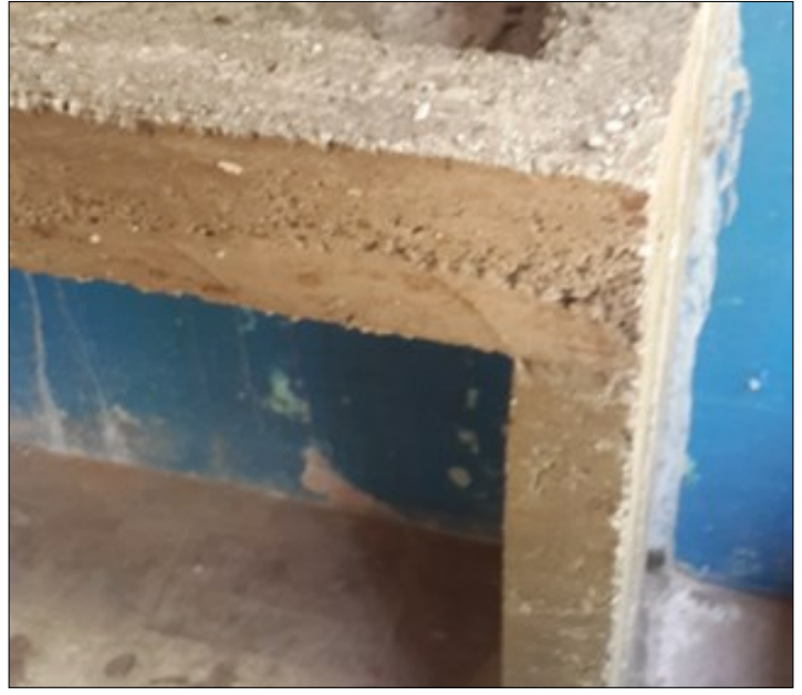
Construcción lavamanos/Fuente:Elaboración propia.
