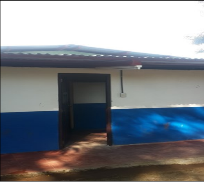
Instalación de luminarias/Fuente:Elaboración propia.
