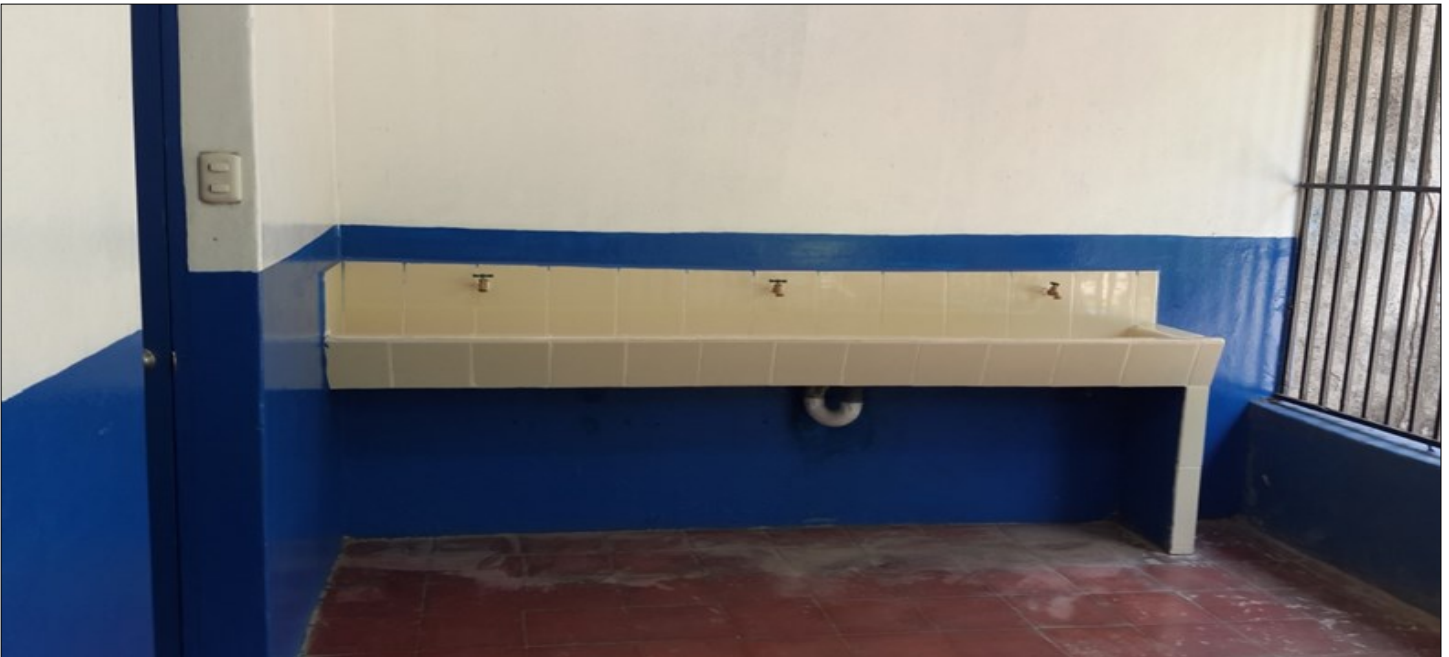
Construcción de lavamanos de concreto/ Fuente:Elaboración propia.
