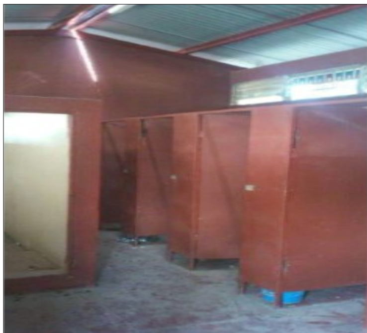
Servicios sanitarios/Fuente:Elaboración propia
