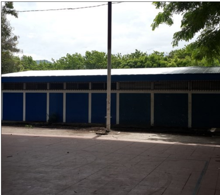
Mantenimiento a techo/Fuente:Elaboración propia.
