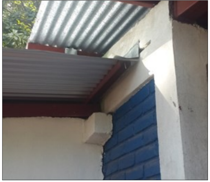
Intalación de flashing/Fuente:Elaboración propia.
