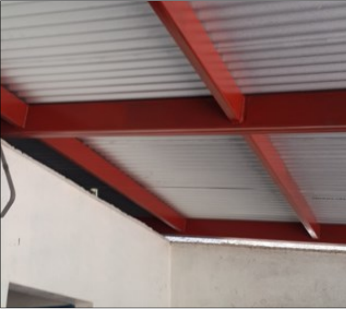
Cambio de cubierta techo/Fuente:Elaboración propia.
