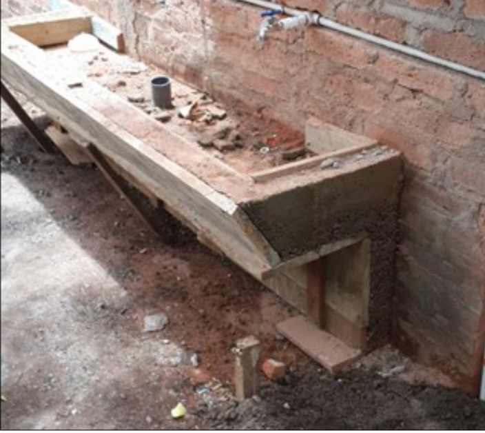
Construcción de bebederos/Fuente:Elaboración propia.
