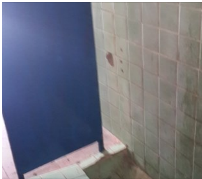
Rehabilitación de Urinario/Fuente:Elaboración propia.
