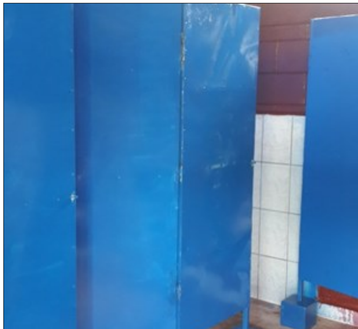
Cambio de puertas/Fuente:Elaboración propia.
