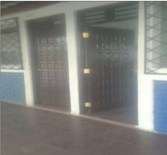
Intalación de nuevas puertas /Fuente:Elaboración propia.
