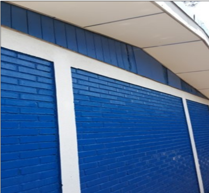
Aplicación de Pintura en paredes externas Fuente:Elaboración propia.
