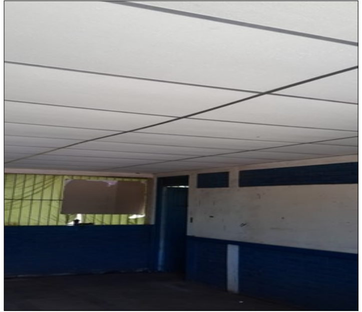
Cambio de Cielo falso/Fuente:Elaboración propia.
