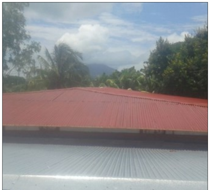
Impermeabilización de cubierta/ Fuente:Elaboración propia.
