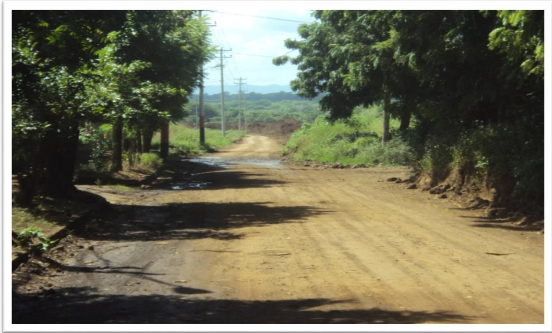
Fotografía 3. Punto Final del Tramo En estudio Est.4+000
