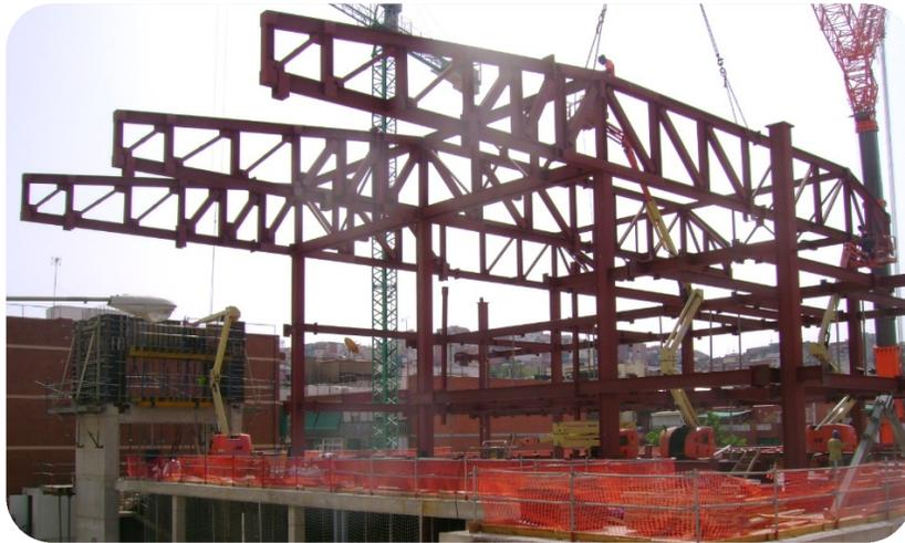
**Fig. 20** Armadura de la estructura de techo de un edificio de acero
