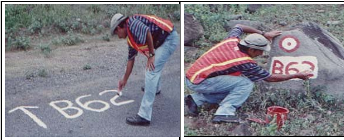
Figura N° 2.2 – Señalización mediante pintura.
