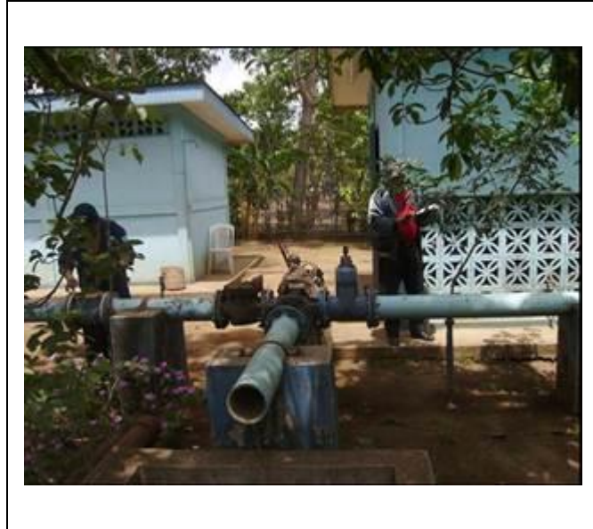
Imagen 1: Fotografía de Pozo 3B actualmente inactivo.
