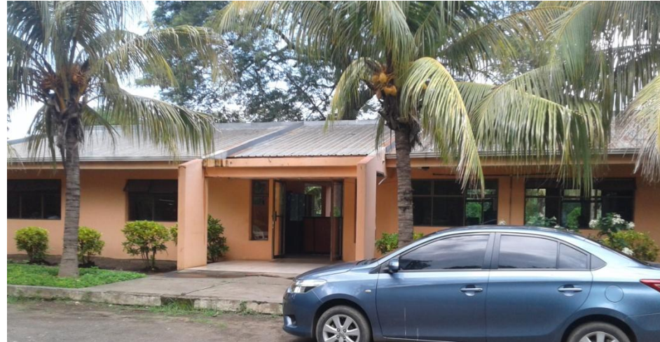
Imagen No. 47 Foto de la fachada principal del edificio Administrativo.
