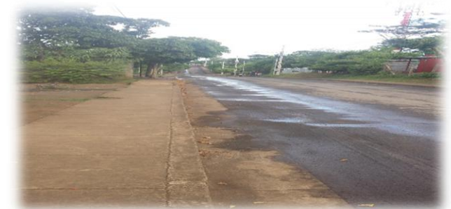
Imagen No.81. Calle de la terminal de la ruta 168.
