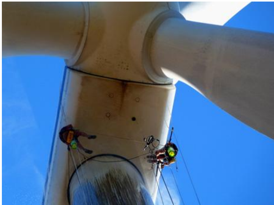
Imagen 2. Limpieza de aerogeneradores mediante trabajos verticales.
