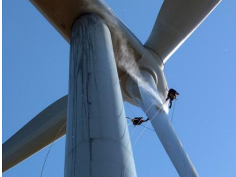
Imagen 1. Limpieza de aerogenerador mediante trabajos verticales.
