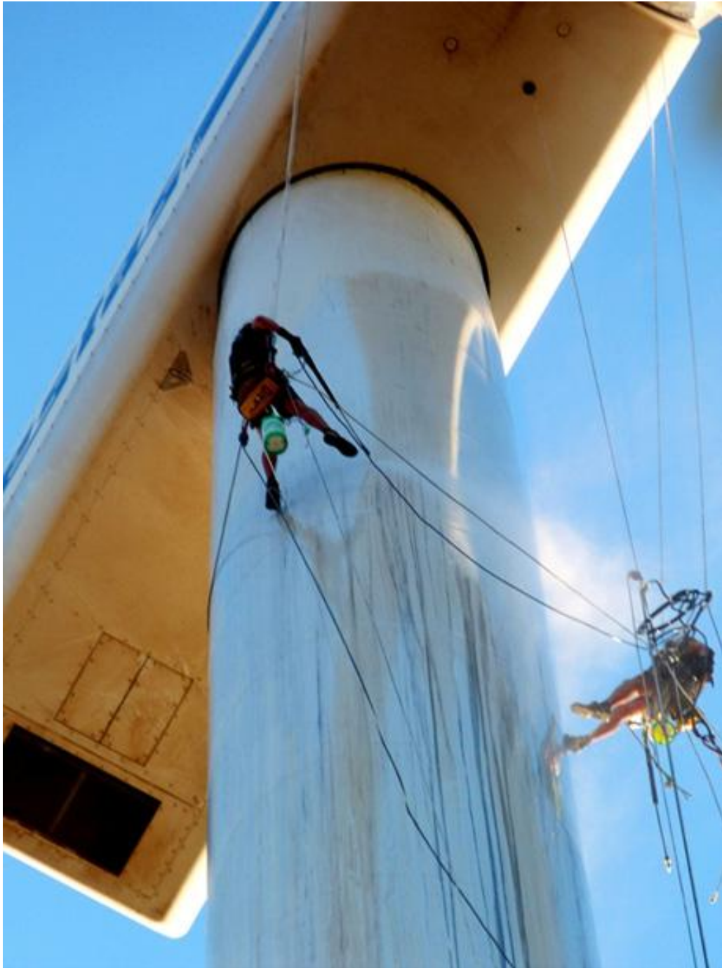
Imagen 3. Limpieza de aerogeneradores mediante trabajos verticales.
