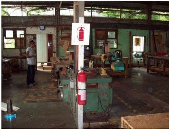
Fig.12: Extintor y su señalización.
