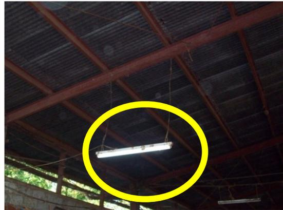
Fig.7: Lámparas mal sujetadas.
