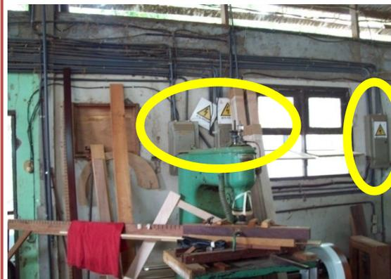
Fig.11: Paneles mal señalizados
