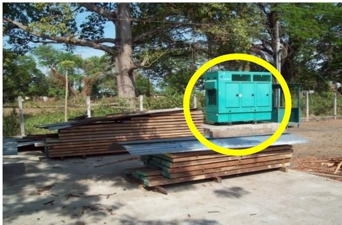
Fig.5: Planta eléctrica no señalizada.
