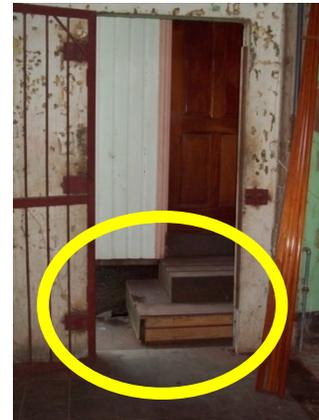
Fig.9: Obstáculo en la puerta de salida
