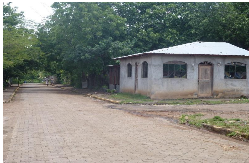
Imagen 25: Calle adoquinado Bo Los Novios
