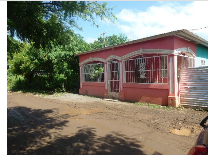
Imagen 33: vivienda urbana progresiva
