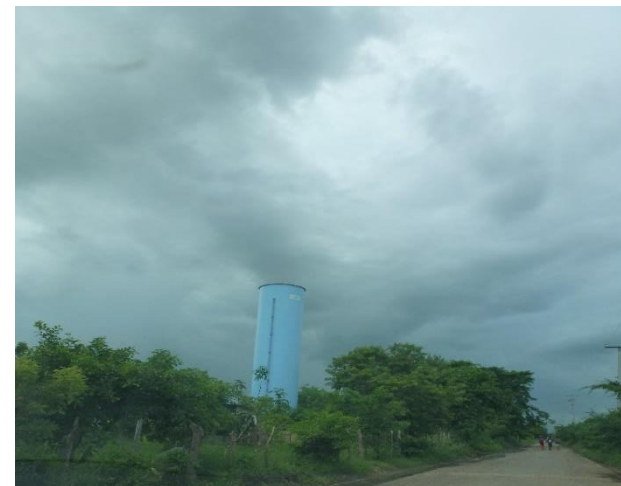
Imagen 32: Tanque de almacenamiento de agua potable
