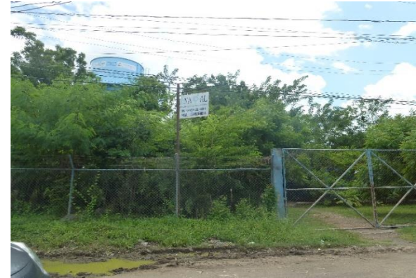
Estación de bombeo ENACAL
