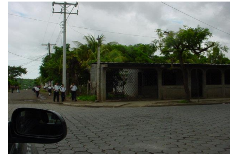
Falta de sistema de drenaje pluvial en ciertas zonas no adoquinadas
