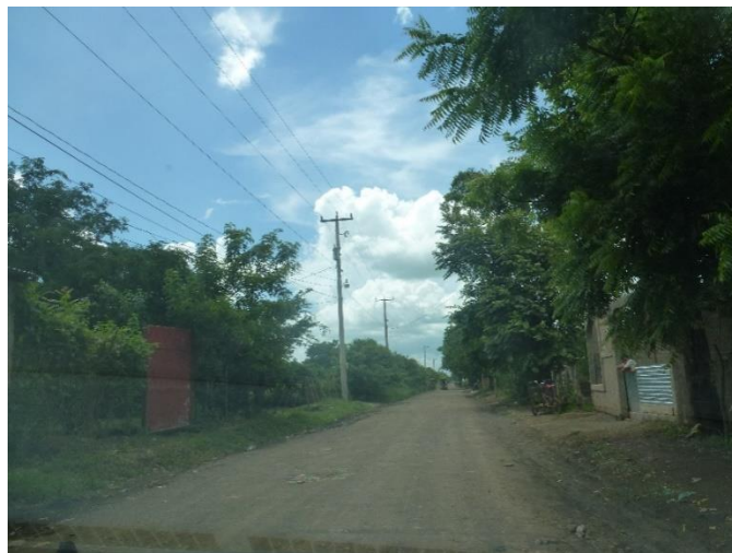
Imagen 31: Tendido de energía eléctrica
