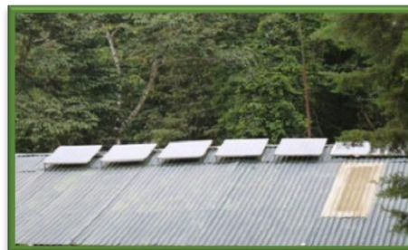
Ilustración 18: Uso de paneles solares para captación de energía.
