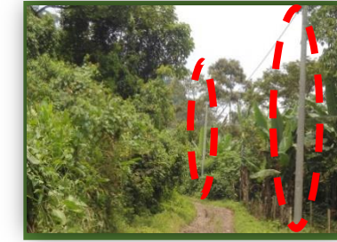
Ilustración 93: Red de electrificación presente en la comunidad.
