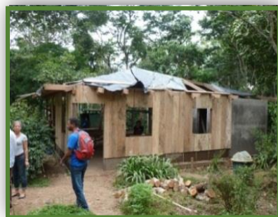
Ilustración 10: Cabaña en construcción.
