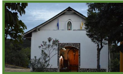
Ilustración 43: Fachada frontal de la iglesia de San Ramón
