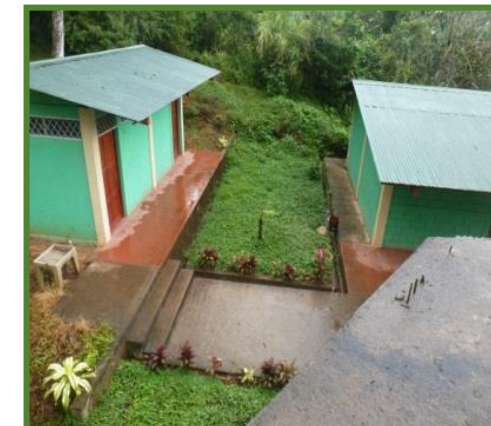
Ilustración 103: Vista aérea de los s.s. y del pabellón.
