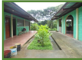
Ilustración 96: Vista de cunetas existentes alrededor de los edificios.
