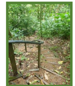
Ilustración 22: Sistema de gradas que se dirigen hacia la cascada
