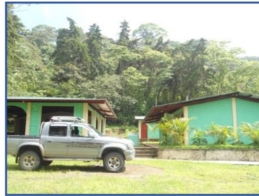
VISTA FRONTAL DEL AREA CONSTRUIDA
