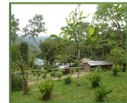
Ilustración 1: Vistas de las instalaciones existentes.
