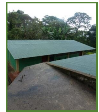
Ilustración 104: Cubierta de zinc corrugado en edificios existentes.
