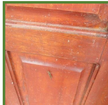
Ilustración 100: Vista de puertas existentes.
