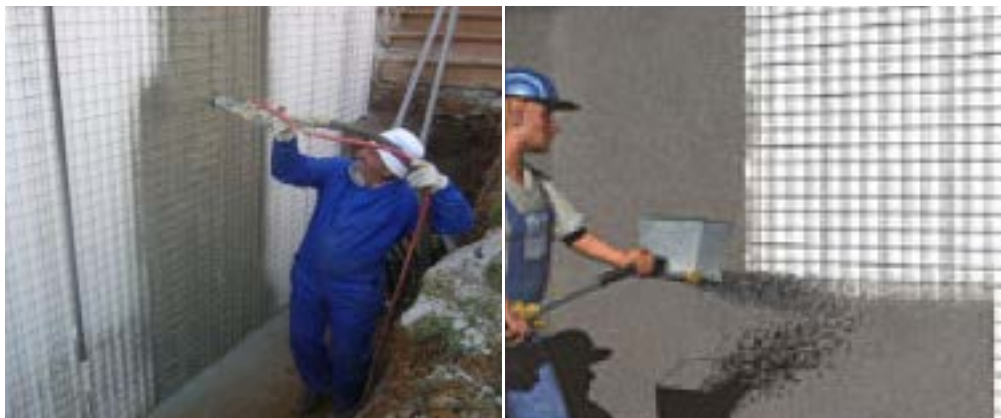
Figura No.1.19. Proceso de revoque de paneles EMMEDUE.
