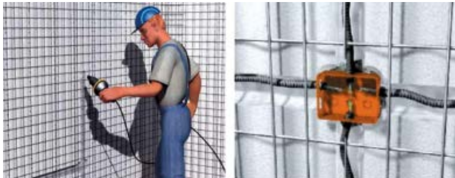
Figura No.1.17. Contracción con fuego del poliestireno para canalización.
