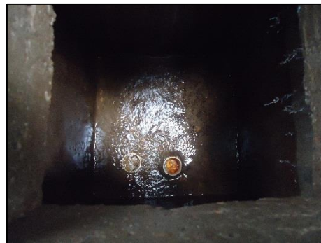
Foto 16. Red de Tuberías y Nivel estático de la captación. Fuente Domínguez-Mora, 2013.
