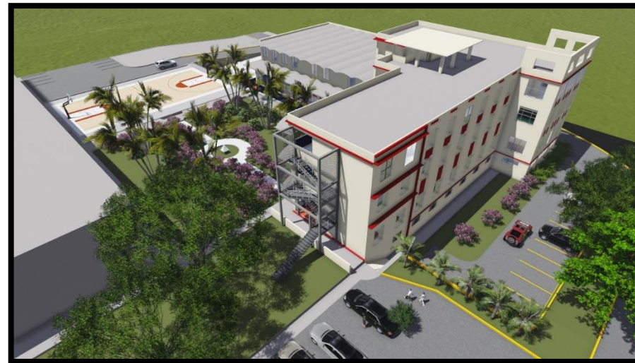
Figura 124 Ubicación de escalera de emergencia
