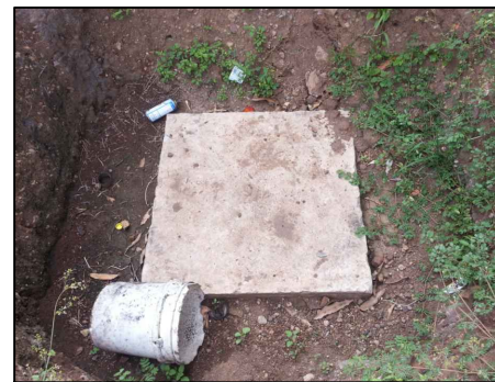
2 - Caja de registro 1.00 x 1.00m.
