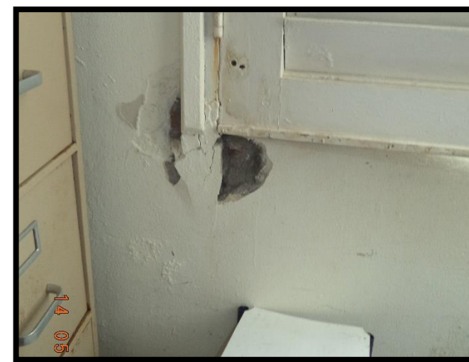
Figura 105 Oquedad por trabajo no concluido en la instalación de marco para la ventana. Recuperado de Archivos Fotográficos Propios, 2015.
