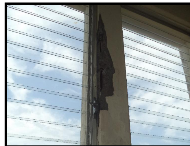
Figura 107 Desprendimiento por trabajo no concluido en la instalación de la ventana en el tercer nivel. Recuperado de Archivos Fotográficos Propios, 2015.
