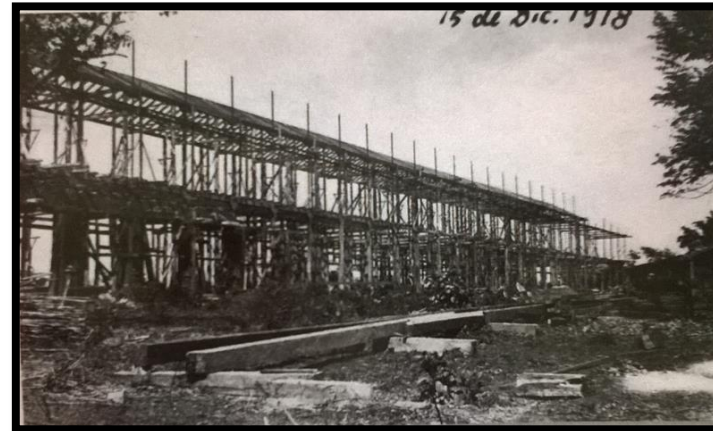
Figura 11. Trabajos de construcción del C.C.A-Granada en 1918. Recuperado de archivos del C.C.A – Managua por A. Fonseca R, L. Osorto N y M. Ramírez de Arellano B.
