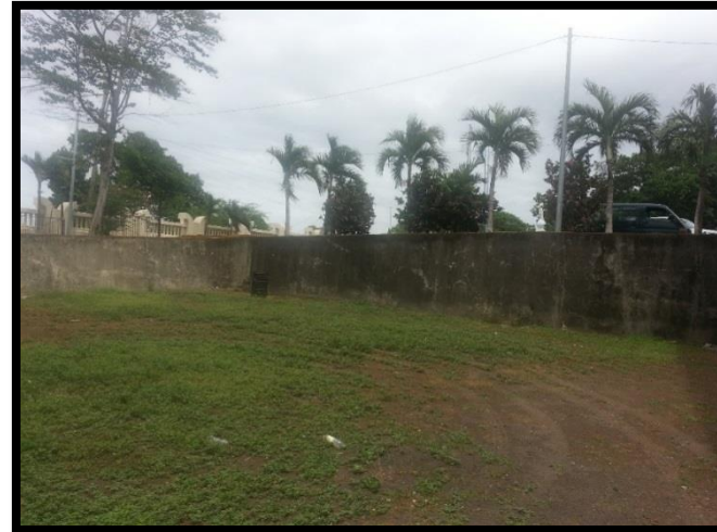
Figura 31 Humedad capilar en muro de contención a causa de la ascensión del agua. Recuperado de Archivos Fotográficos Propios, 2015.
