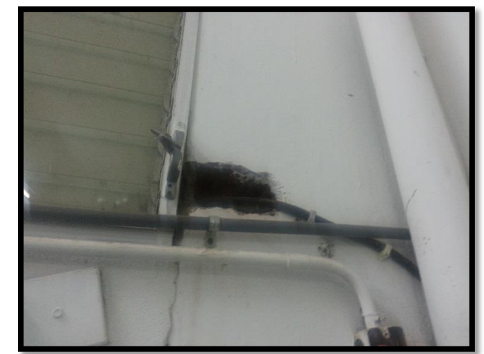
Figura 104 Oquedad por trabajo no concluido en la instalación de canalización eléctrica en aula de electrónica primer nivel. Recuperado de Archivos Fotográficos Propios, 2015.
