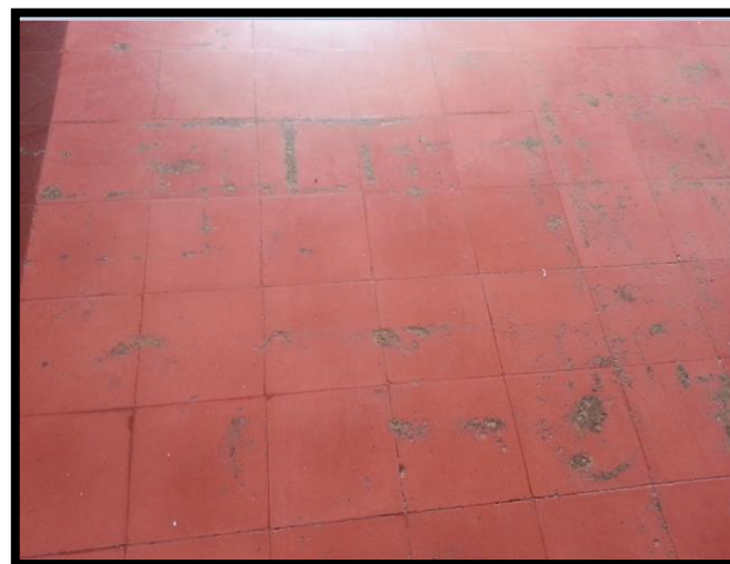
Figura 103 Erosión en pisos por abrasion de objetos pesados del pasillo del primer nivel. Recuperado de Archivos Fotográficos Propios, 2015.
