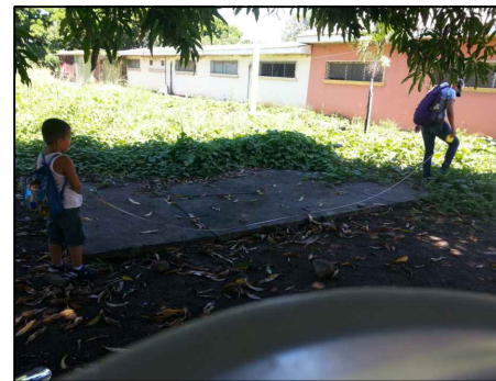
3 - Pila de desechos sólidos 2.65 x 5.90m.
