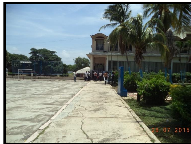
Figura 33 Grietas en Andén por esfuerzo rasante. Recuperado de Archivos Fotográficos Propios, 2015.
