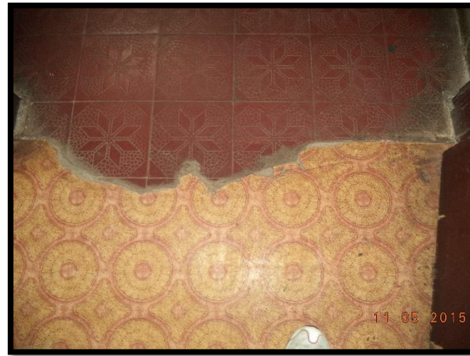
Figura 101 Erosión en piso vinílico por del bienestar estudiantil del primer nivel. Recuperado de Archivos Fotográficos Propios, 2015.
