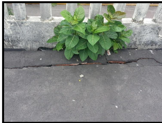
Figura 71 Desprendimiento del ladrillo chiltepe Recuperado de Archivos Fotográficos Propios, 2015.
