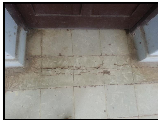
Figura 102 Erosión por instalación de tuberías en piso del pasillo del tercer nivel. Recuperado de Archivos Fotográficos Propios, 2015.
