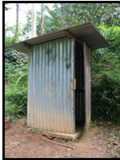
Fotografía No 32: Letrinas. Comunidad El Jícaro
