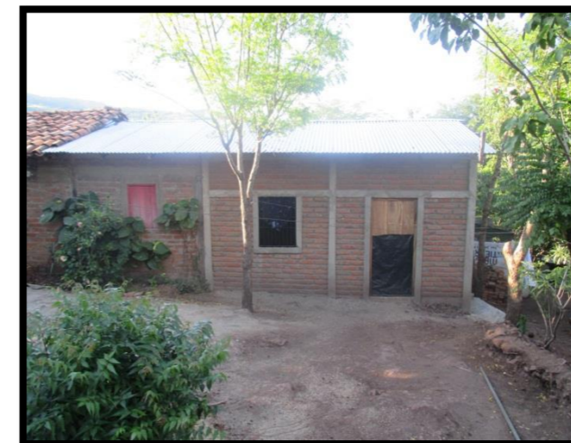
Fotografía No 23: Vivienda Mampostería Confinada. Bo. El Castillo
