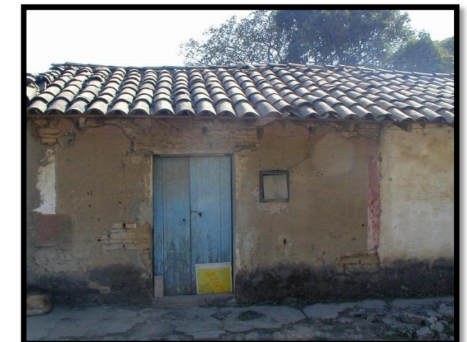
Fotografía No 24: Vivienda de Adobe y Teja. Bo. San Antonio
