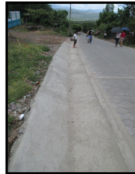
Fotografía No 18: Cunetas - Drenaje Pluvial.
