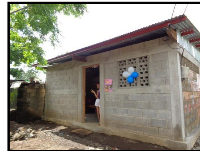
Fotografía No 33: Vivienda de mampostería reforzada implementada por el INVUR. Bo. El Castillo
