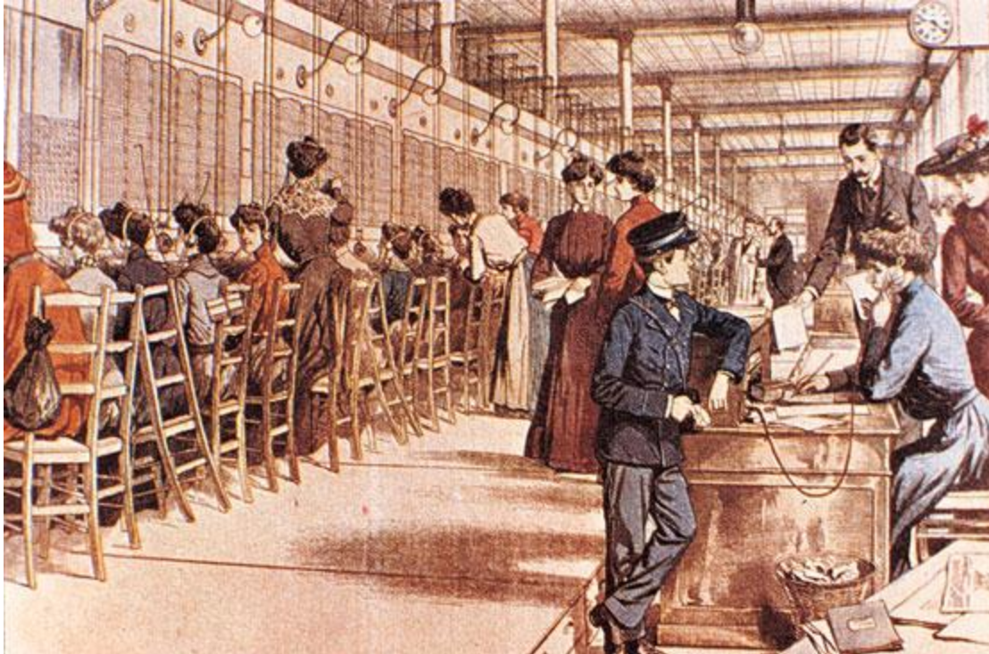
Figura 2-1 Antigua Central Telefónica
