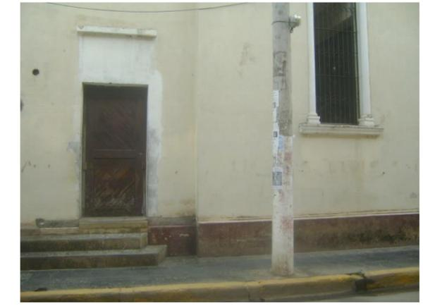
Fotografía #65: puerta lateral de madera machimbrada.
