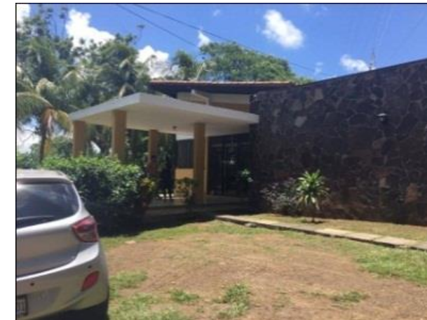
Ilustración 38 Casa de servicio #1
