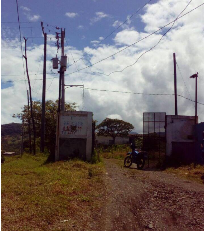
Ilustración 24 Entrada principal al sitio
