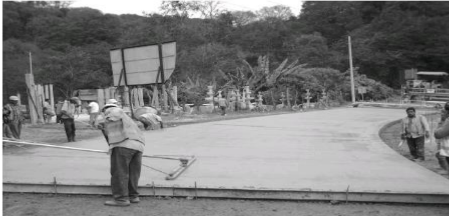
Figura 25 Fotografía de junta transversal de construcción
