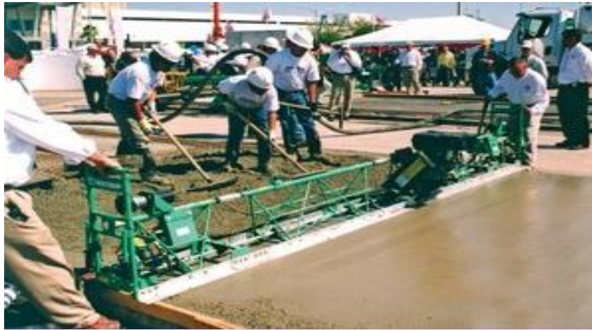
Figura 7. Regla vibratoria manual para trabajos pequeños
