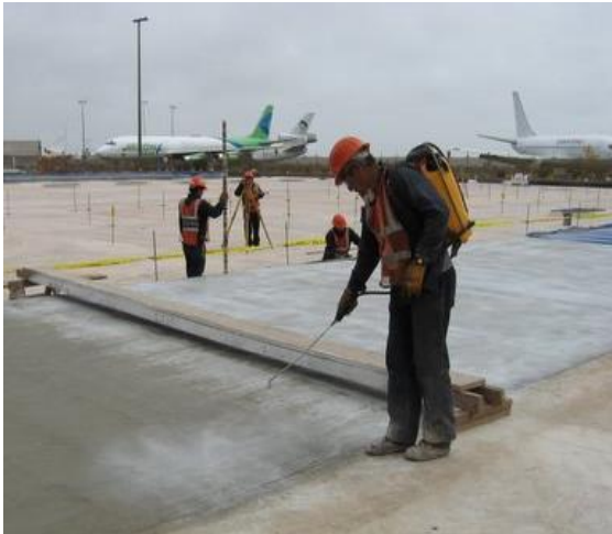
Figura 20.-curado con bomba manual.
