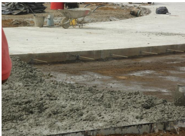
Figura 27 Fotografía construcción de junta longitudinal sin formleta.
