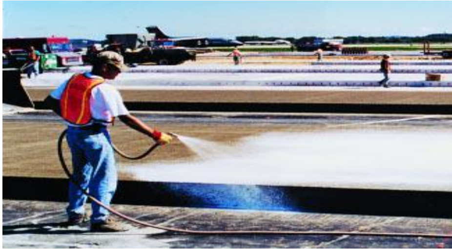
Figura 31 Los compuestos líquidos formadores de películas se deben aplicar con cobertura uniforme y adecuada sobre toda la superficie y bordes para obtenerse un curado prolongado y efectivo
