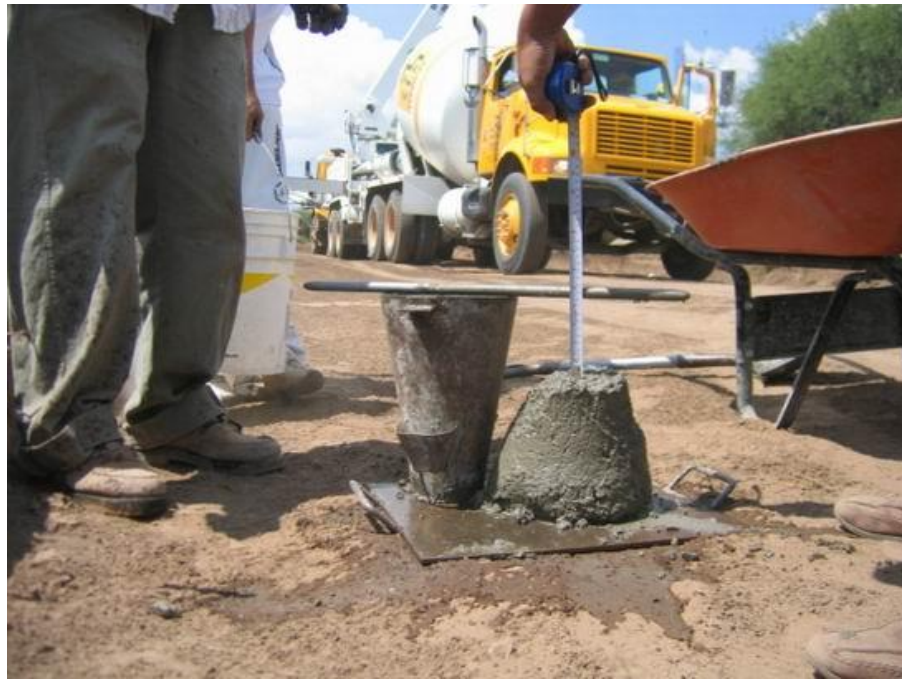
Figura 2. Determinación del Revenimiento del Concreto mediante Cono de Abrahams
