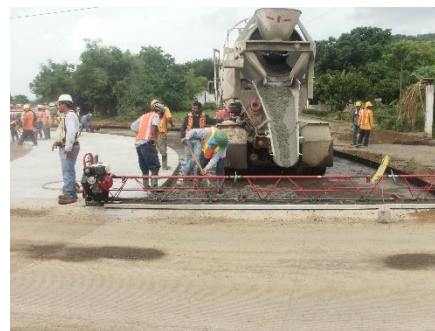
Figura 12. Descarga frontal.
