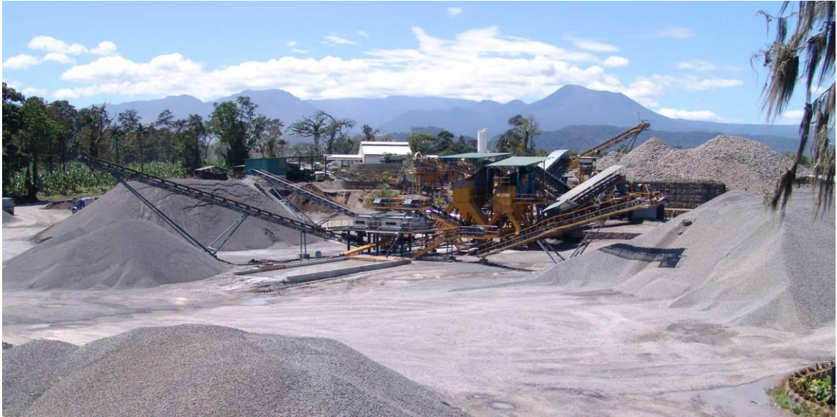
Figura 3. Distribución Organizada de los Materiales y Planta de Concreto para una adecuada logística de suministro.
