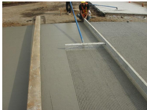
Figura 18. Texturizado transversal manual.
