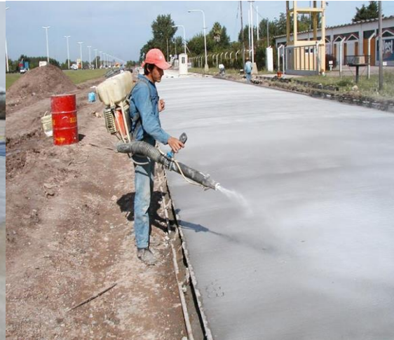
Figura 21. Curado con bomba de motor.
