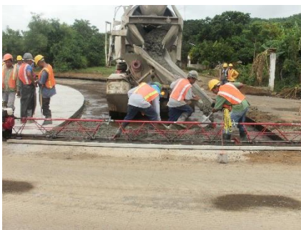
Figura 11. Descarga lateral.
