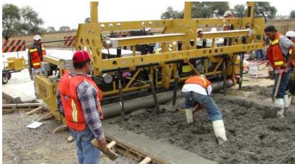
Figura 6 . Colocación mediante extendedora de rodillos nivelables.
