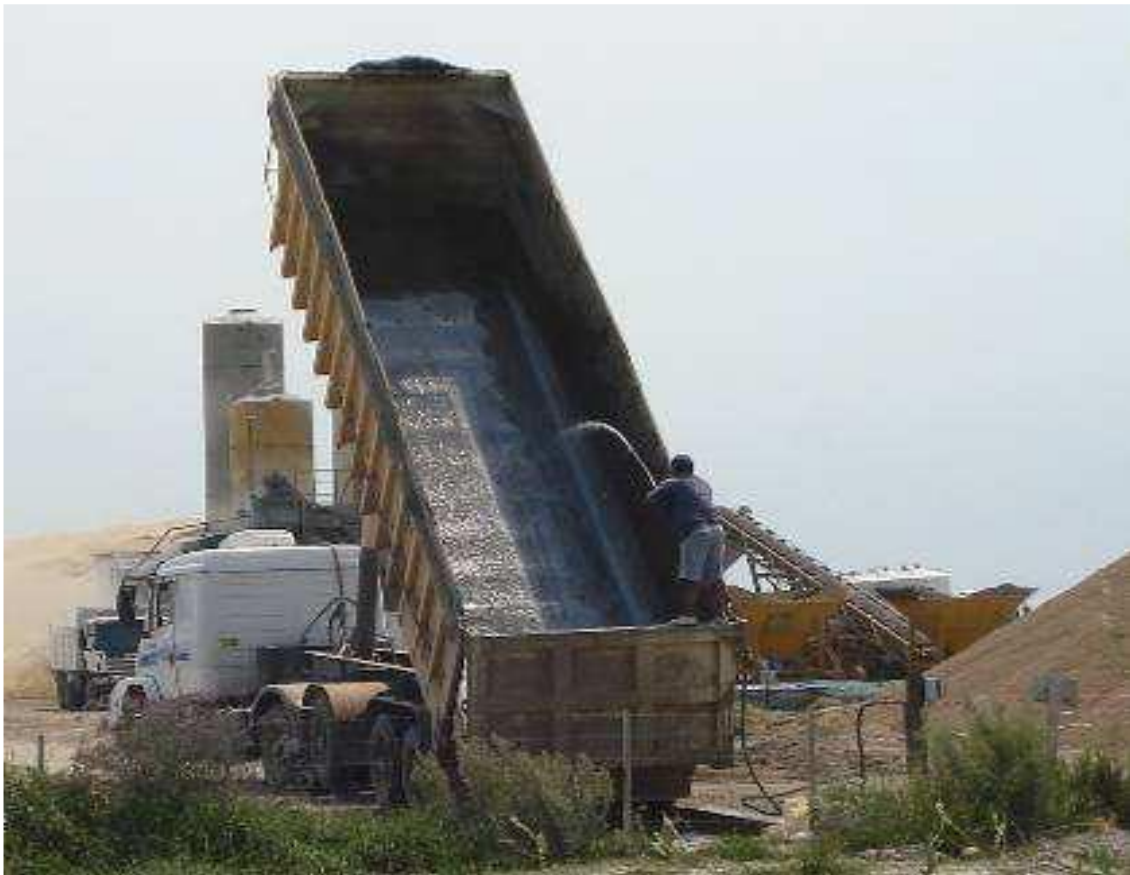
Figura 4. Limpieza periódica de los camiones volquetes y eliminación de residuos de concreto,
