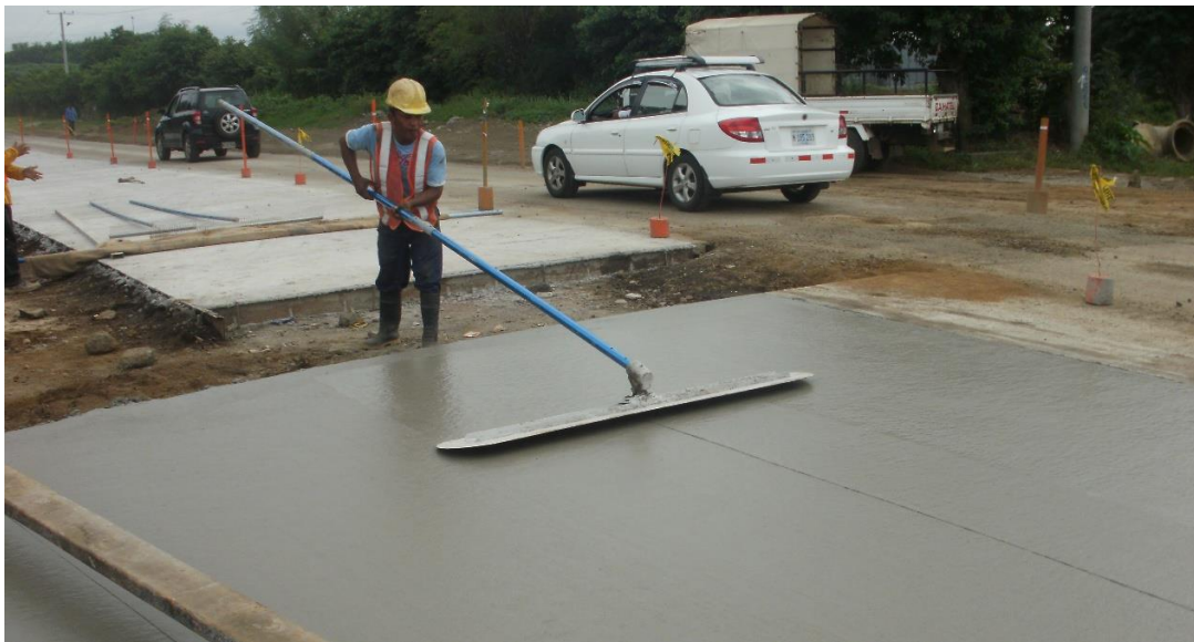
Figura 13. Llana automáticas incorporadas al tren de pavimentación.
