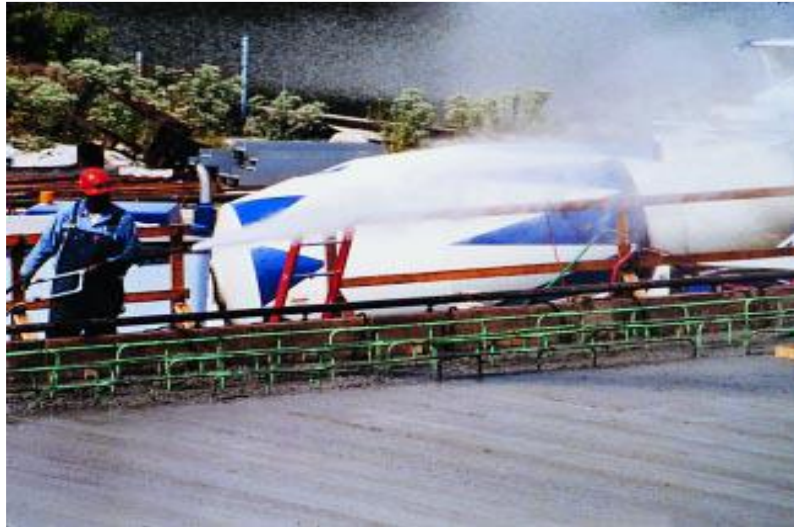
Figura 32 Medidas adicionales de curado: la niebla minimiza la pérdida de humedad durante y después de la colocación y el acabado del concreto.
