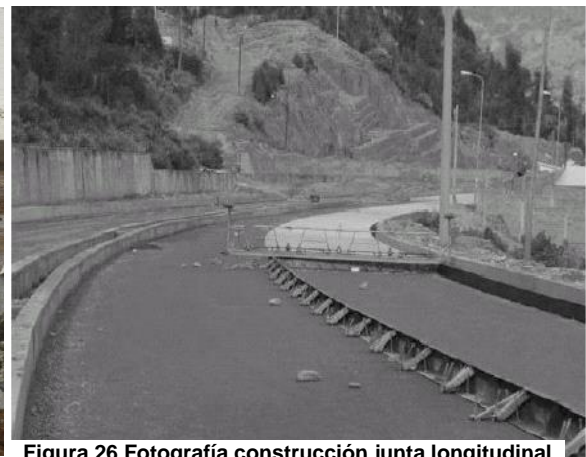
Figura 26 Fotografía construcción junta longitudinal con formleta.
