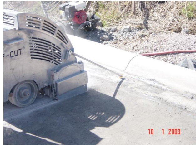
Figura 22. Corte de junta transversal.
