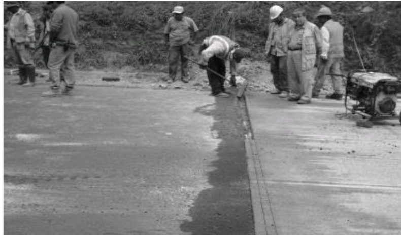
Figura 29. Fotografía de construcción de junta longitudinal construida al final del pavimento nuevo y un pavimento existente
