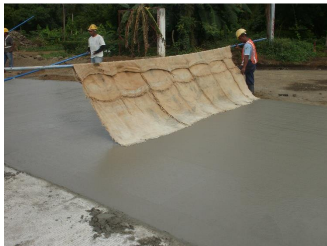
Figura 16. Equipo de texturizado longitudinal.
