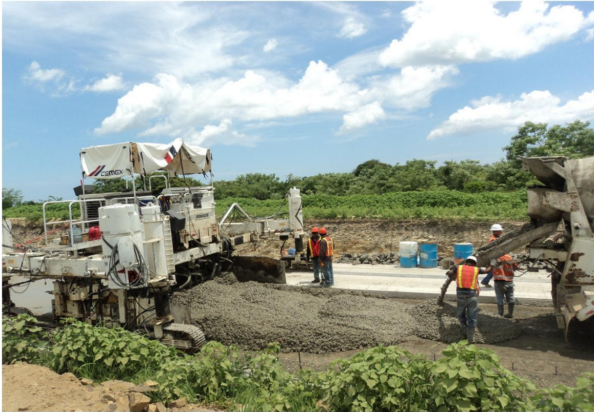
Figura 9. Forma adecuada para abastecer la pavimentadora de manera continua para que el proceso tenga éxito.
