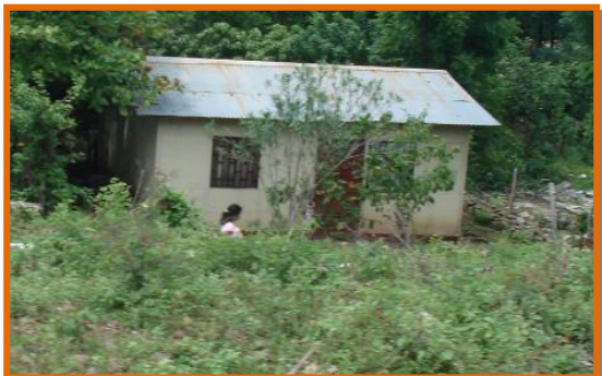
Foto 59: Vivienda en Lomas del Sol. Tomada por: Grethel Valle, 2010
