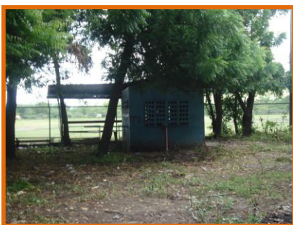
Foto 77: Bomba de Agua. Tomado por: Grethel Valle. Año 2010
