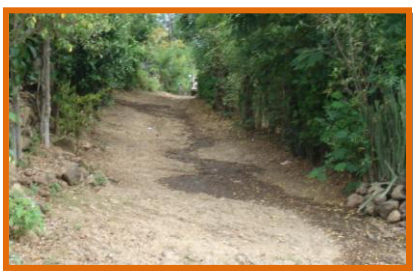
Foto 79: Vista de aguas Pluviales. Tomado por: Grethel Valle. Año 2010
