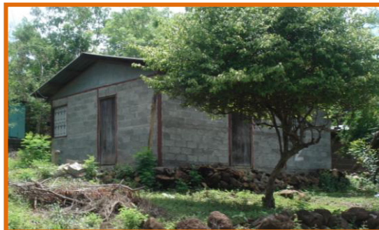
Foto 60: Vivienda de Bloque de concreto con perlines metálicos. Tomada por: Grethel valle, 2010
