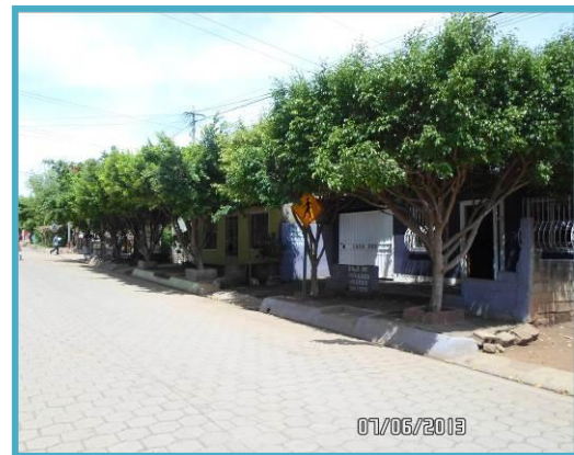
Imagen 6 Obstaculización de aceras por cajas de árboles y rampas
