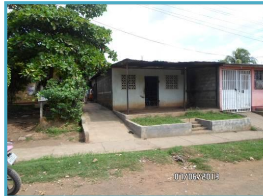
Imagen 5 Adaptación de viviendas mediante plano base elevada
