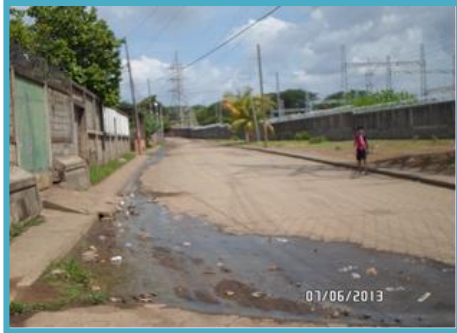
Imagen 18 Subestación eléctrica y presencia de aguas grises en las calles
