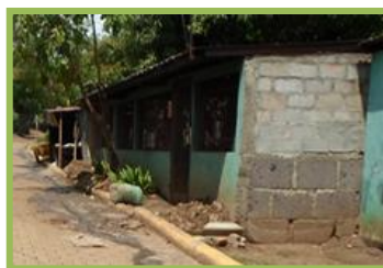
Imagen 23 Vivienda mixta (piedra cantera-mampostería)
