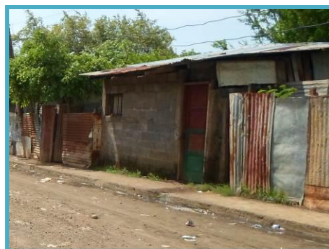
Imagen 21 Vivienda del Bo. Tangara
