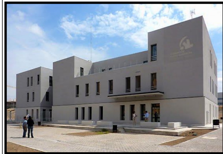
Fotografía Centro de Rehabilitación Padre Garralda Fuente: Blog Puerta Verde, arquitectura + urbanismo
