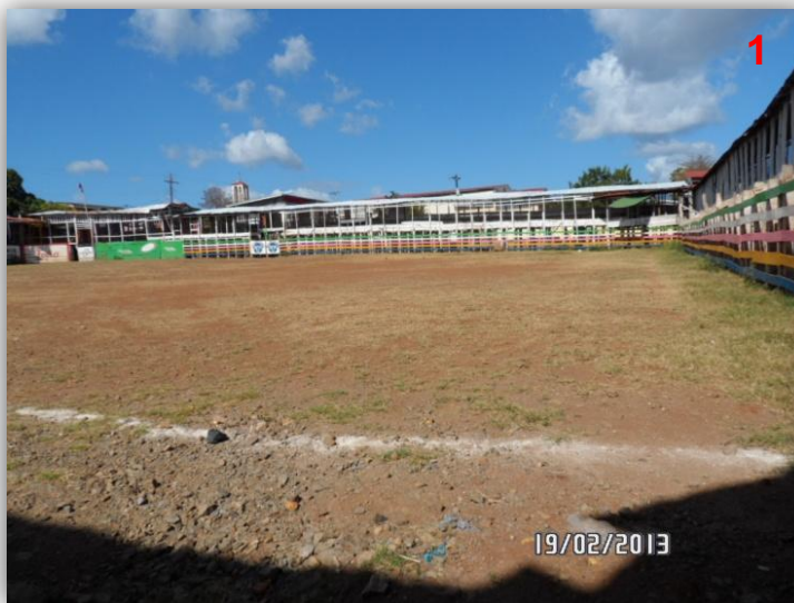
Foto Nº 30: Vista hacia el centro del terreno.
