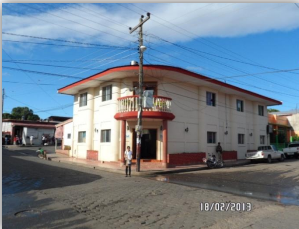
Foto N° 4: Costado norte del Mercado Municipal, 1976 a 1998
