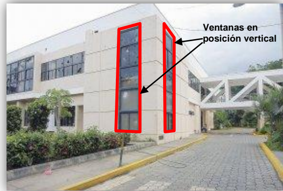
Foto N° 16: Vista norte del edificio principal y puente aéreo
