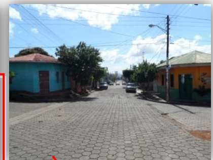
Foto N° 35: Calle de acceso al terreno por el costado Sureste
