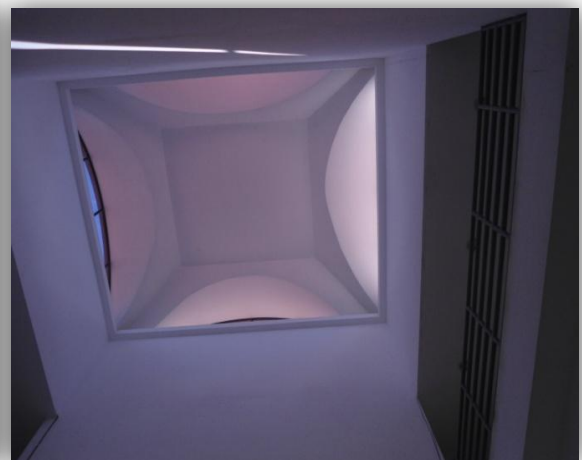
Foto N° 21: Vista de atrio central en el edificio principal
