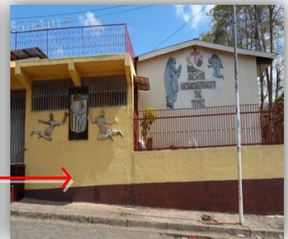
Foto Nº 33: Colegio San Francisco de Asís
