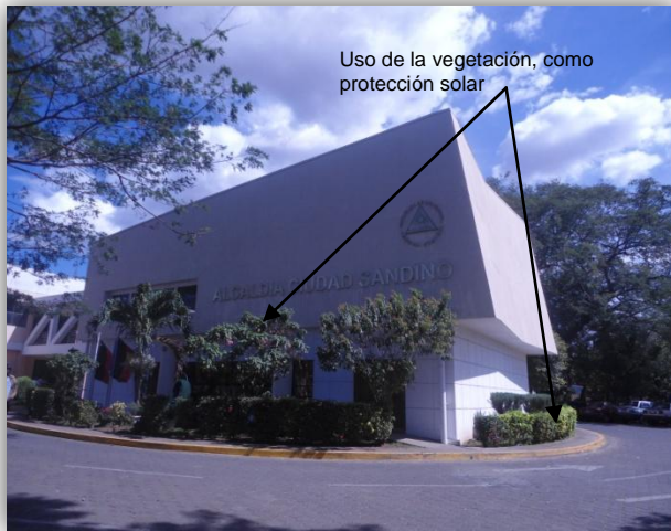
Foto N° 20: Fachada Norte del Auditorio
