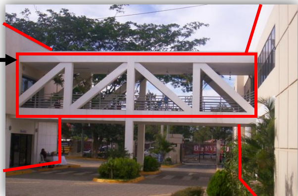
Foto N° 13: Vista sur del puente Aéreo
