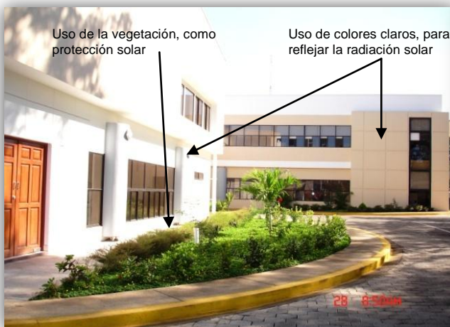
Foto N° 22: Vista Sur del Auditorio y vista oeste del edificio principal
