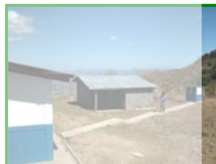
Vista del agrupamiento 3 (Cocina) y las letrinas.
