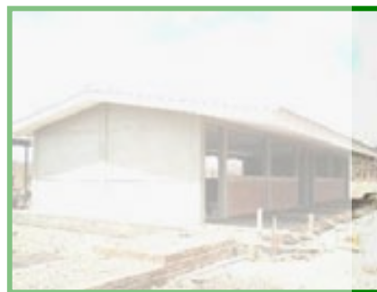
Vista del agrupamiento en construcción.
