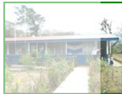
Vista parcial del agrupamiento 1 (aulas de clases).
