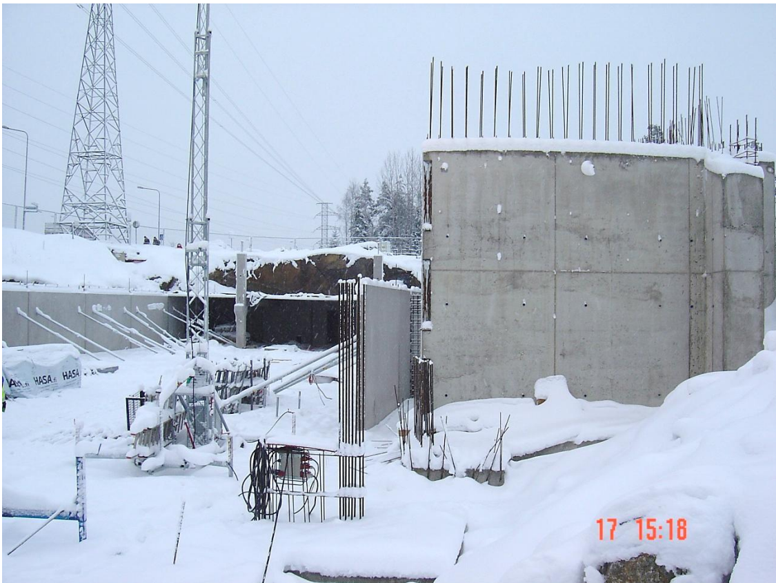
Kuvio 5 Rakennustyömaa Tampereen Hervannassa 17.01.2012. YIT Oyj.
