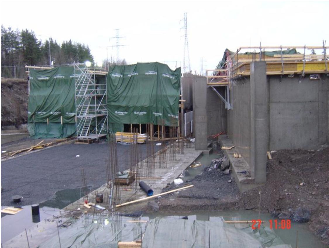
Kuvio 4 Rakennustyömaa Tampereen Hervannassa 27.12.2011. YIT Oyj.
