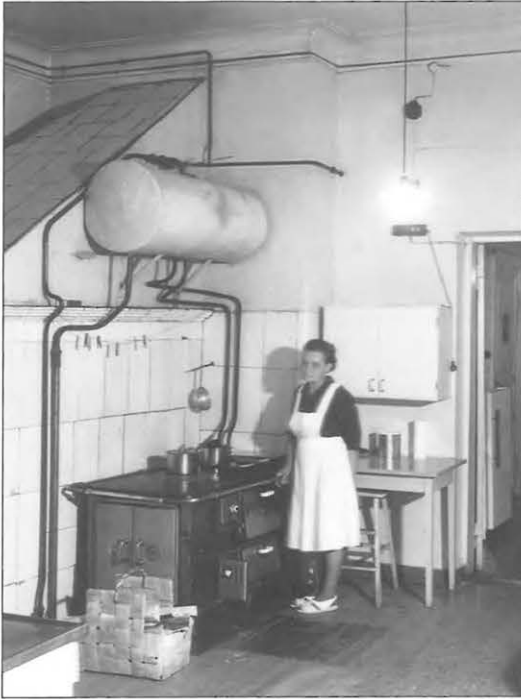
Kuva 12.1. Lämminvesijohto puuttui 1900-luvun alussa varakkaistakin talouksista, ja vesi kuumennettiin hellalla tai käytettiin hellan pientä kuumavesisäiliötä. Vuosisadan vaihteessa tulivat Suomessa käyttöön suuret vesiboilerit ja puuhellat, joiden sisällä kiersi vesijohto. Oheinen kuva on myöhemmältä ajalta keittiöstä Katiselta vuodelta 1967. (HKHM valok. Welin, Turku)
