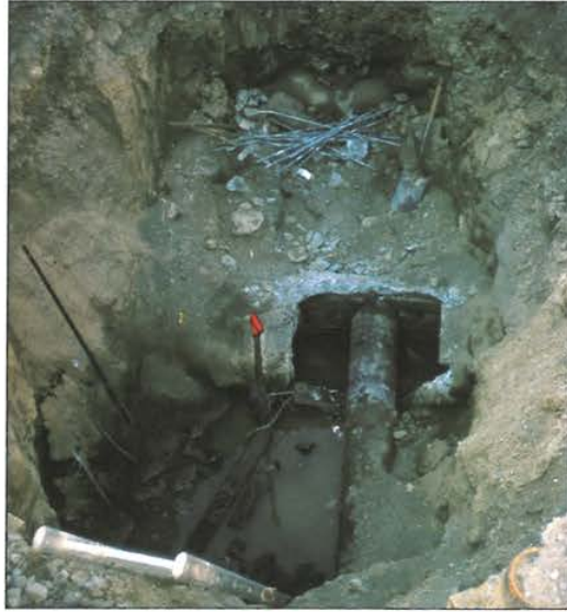
Kuva 7.20. Piilovuoto 1970-luvulla. Parolantien ja Torikadun kulmassa juoksi vettä suoraan viemäriin 2000 kuutiota vuorokaudessa. (VL)
