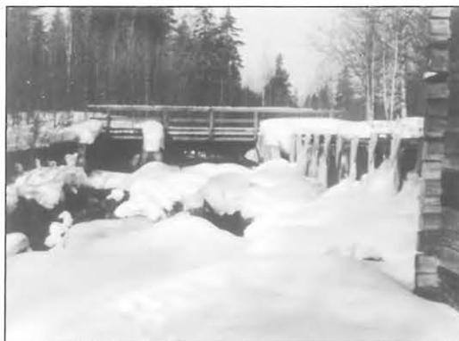
Kuva 10.5. Alajärvestä pumpataan vettä Ahveniston harjun imeytysaltaaseen ja sadetukseen. Kuvassa Katiskosken pato, joka säätelee Alajärven vedenpintaa. (Salo)
