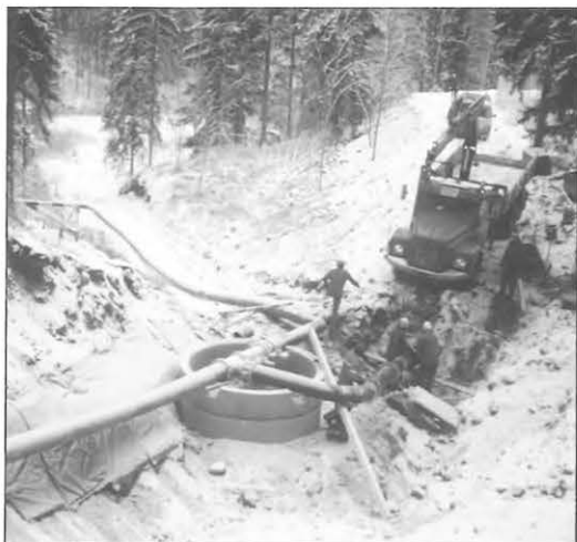
Kuva 10.4. Tekopohjavesilaitoksen imeytysaltaiden venttiilikaivo rakenteilla 1976. (VL)
