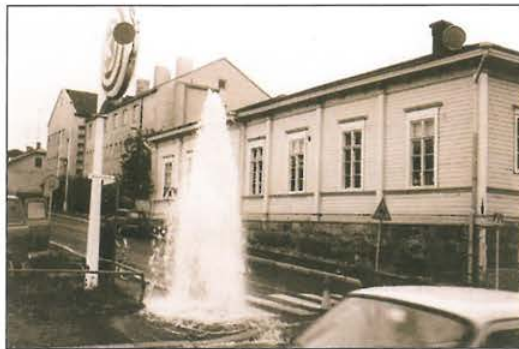
Kuva 7.9. Verkoston huuhtelua eli puulausta Kaivokadulla vuonna 1976. Virtausnopeutta nostamalla saadaan raudan ja mangaanin aiheuttamat saostumat poistumaan vesijohdoista. (VL)
