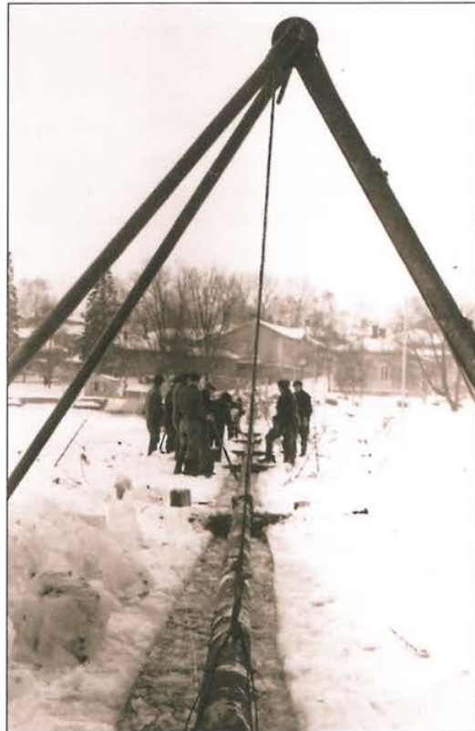
Kuva 6.4. Verkostoa uusitaan vuonna 1934. Kuvassa uusitaan Palokunnankadun viemäriä linja-autoaseman kohdalla. Putket ovat lasitettuja saviputkia eli ns. ruukkuputkia. (HKHM)
