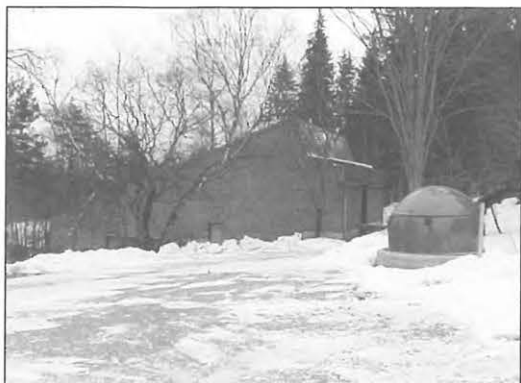
Kuva 8.9. Kylmälahden vuonna 1969 valmistunut pohjavedenottamo. Etuoikealla vuonna 1997 rakennettu putkikaivo. (VL)
