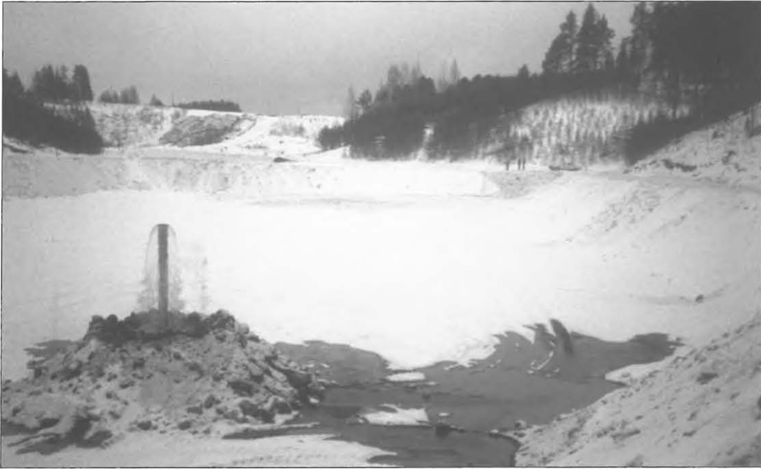
Kuva 10.6. Vuonna 1985 valmistuneet uudet imeytysaltaat. Kuvassa veden syöttö on juuri aloitettu. (VL)
