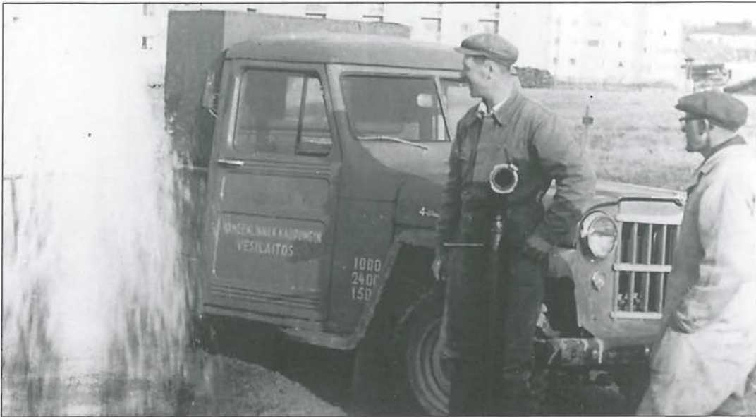
Kuva 7.8. Verkoston huuhtelua eli puulausta 1960-luvulla Brahenkadun ja Uhrikivenkadun risteyksessä. Kuvassa vasemmalla Eino Suvanto ja oikealla Ville Mujo. (VL)
