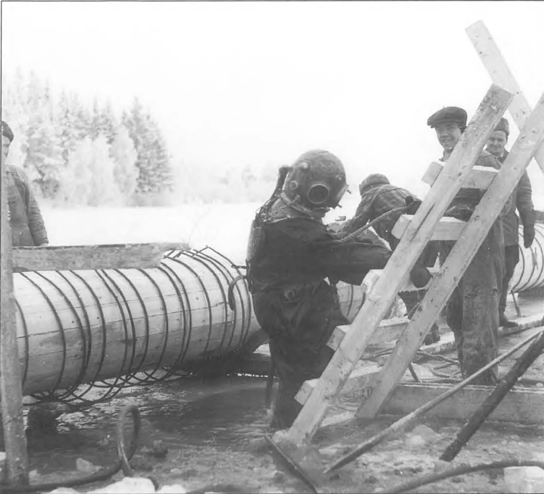
Kuva 9.2. Katuman pintavedenkäsittelylaitoksen imuputken laskussa helmikuussa 1955 tarvittiin apuna sukeltaja Toivo Roiskoa. (VL)
