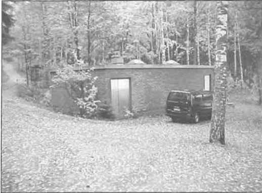
Kuva 10.2. Alajärven tekopohjavedenottamo valmistui vuonna 1976. Kuvassa pumppaamorakennus 1999. (Manninen)
