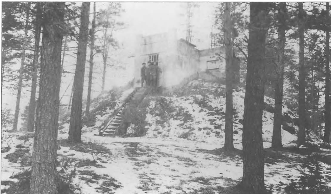
Kuva 5.4. Ahvenistolle vuonna 1910 rakennettu ylävesisäiliö, jonka suunnitteli Jalmari Castren ja jonka pääurakoitsijana oli R. Helanderin sementtivalimo. Säiliötä laajennettiin vuonna 1937. Kuva on vuodelta 1934. (HKHM)
