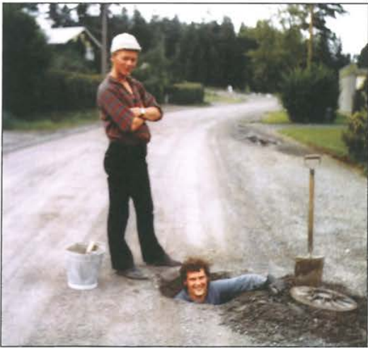
Kuva 7.12. Vuonna 1967 Hämeenlinnassa siirryttiin sekaviemäroinnistä erillisviemärointiin. Viemäriverkostosta poistettiin tarkastuskaivojen lietepesiä ja viemärit varustettiin pohjakouruilla. Kuvassa tarkastuskaivon pohjakourua valamassa Jouko Lepänen ja Taisto Levänen (montussa). (JVL)
