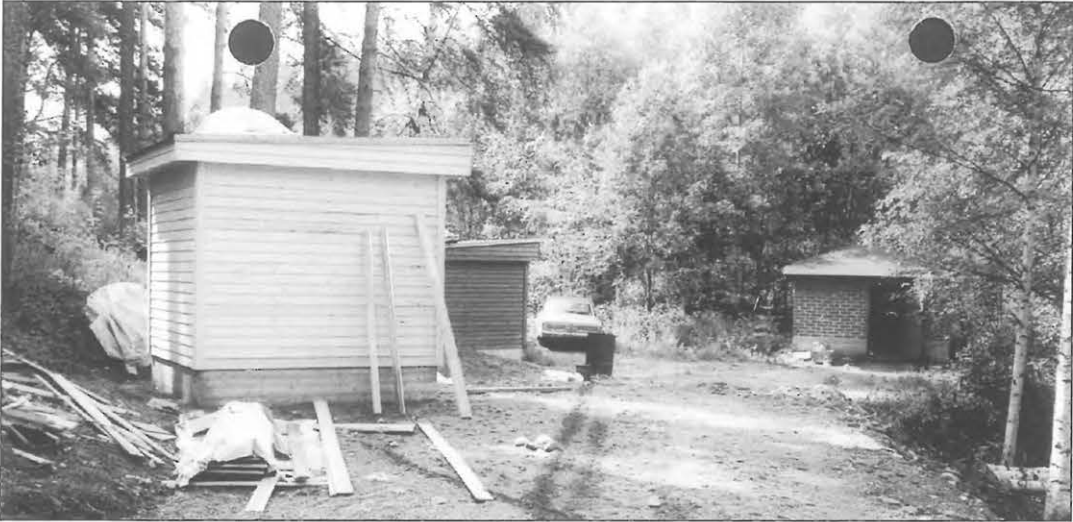
Kuva 8.13. Vasemmalla vuonna 1978 valmistuneet Ahveniston siiviläputkikaivot. Takana oikealla punatiilinen vuonna 1942 rakennettu kuilukaivo. (VL)
