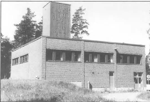
Kuva 8.16. Vuonna 1981 valmistunut Ahveniston uusi pohja- ja tekopohjavedenkäsittelylaitos. (VL)
