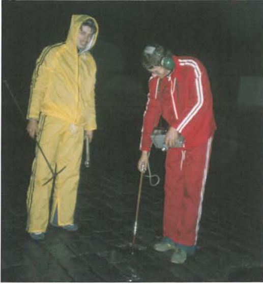
Kuva 7.25. Vuotojen kuuntelua mikrofonilla Lukiokadulla vuonna 1978. Kuuntelijat Esko Toivonen ja Seppo Isosalo. (VL)
