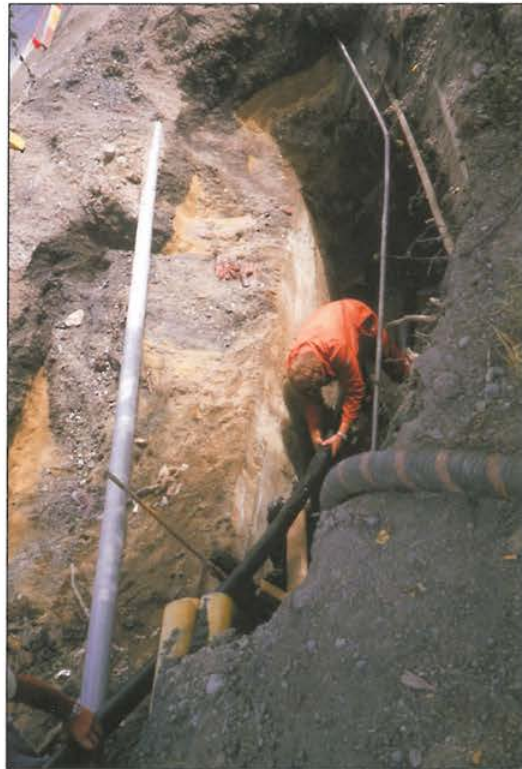
Kuva 7.15. Raimo Levänen sujuttamassa 90 mm:n muoviputkea 150 mm:n teräsputken sisään Tampereentiellä kesällä 1986. (VL)
