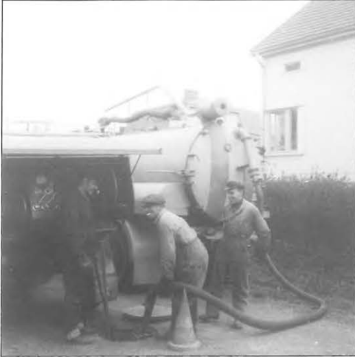
Kuva 11.4. Viemärinpuhdistajat vasemmalta Taisto Levänen, Paavo Rumbin ja Pentti Saha. Kuvassa myös viemärin huuhteluauto "Unimoc" (vasemmalla) ja viemärin imuauto "Bedford". (JVL)
