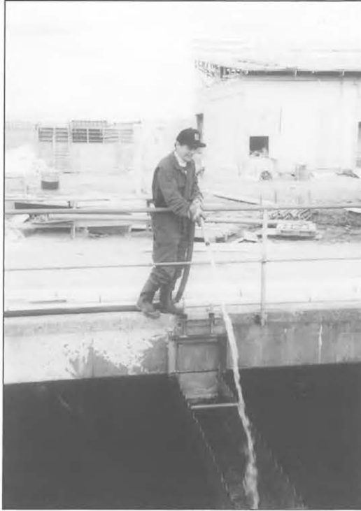
Kuva 11.5. Puhdistuslaitostyöntekijä Kalle Kämi pesee jälkiselkeytysaltaita Paroisten puhdistamon toisen laajennuksen työmaalla vuonna 1990. (Kämi)
