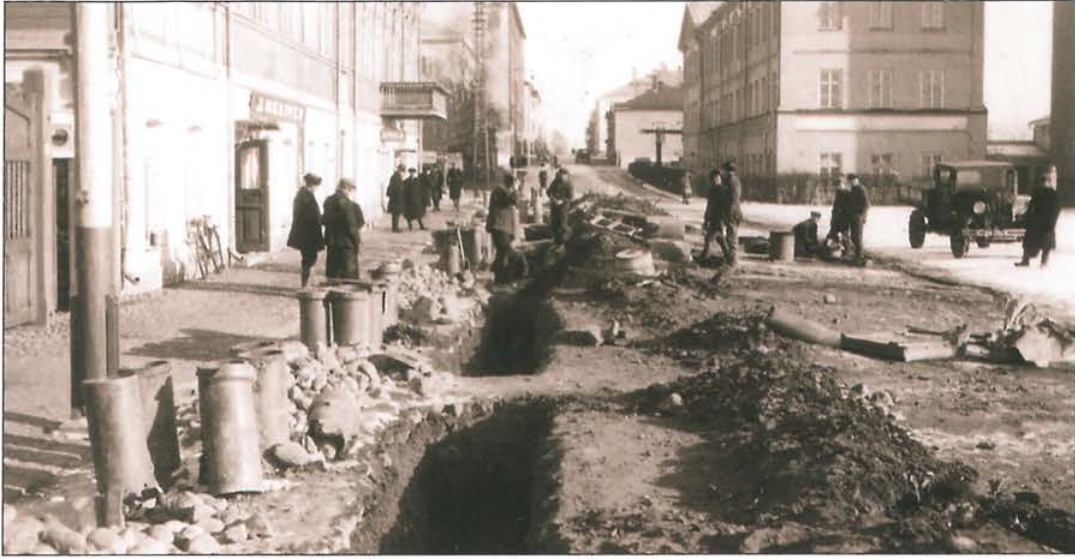
Kuva 6.4. Verkostoa uusitaan vuonna 1934. Kuvassa uusitaan Palokunnankadun viemäriä linja-autoaseman kohdalla. Putket ovat lasitettuja saviputkia eli ns. ruukkuputkia. (HKHM)
