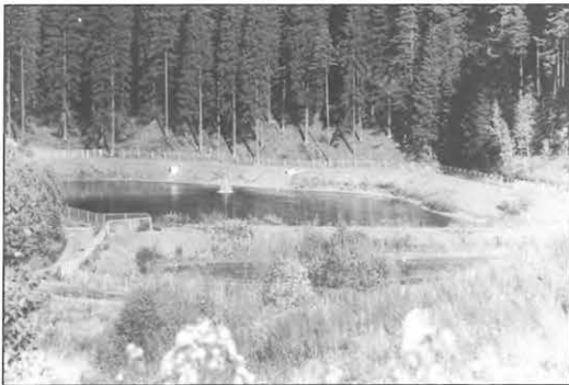
Kuva 10.7. Ahveniston harjuun rakennettiin vuonna 1985 uusi kaksiosainen imeytysallas. Sadeimeytyksellä pyritään korvaamaan nämä altaat, mutta vuonna 1999 niitä käytettiin edelleen tarpeen vaatiessa. (Salo)
