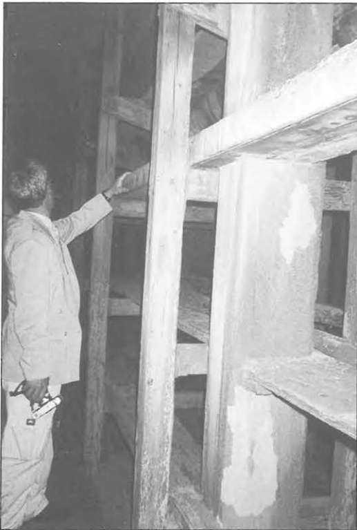
Kuva 8.4. Vuonna 1951 valmistuneessa vesitornissa oli vedenkäsittelyn ensimmäisenä vaiheena ilmastus. Kuvassa ilmastushuoneen puiset ilmastuslaitteet, joissa vesi valui alaspäin puulavalta toiselle. Pudotessaan vesi särkyi pisaroiksi ja siinä oleva rauta muodosti rautahydroksideja, jotka poistettiin vedestä selkeyttämällä ja suodattamalla. (Juuti)
