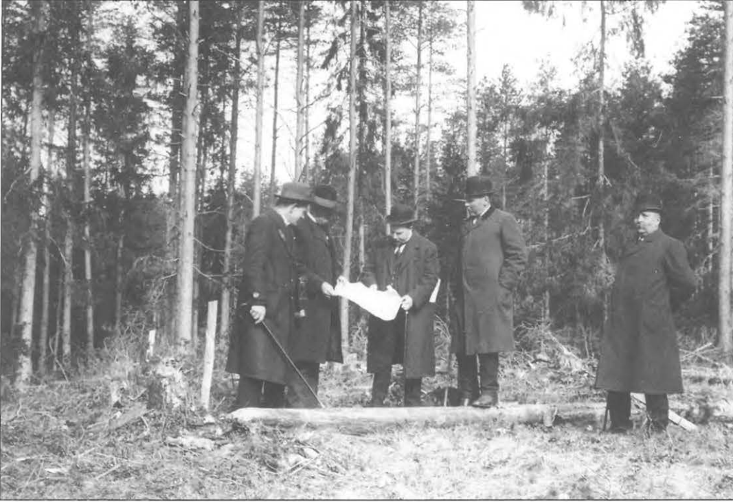
Kuva 4.1. Vesijohtotoimikunta tutkimassa Ahveniston harjulla 1909 tulevaa vesilaitoksen paikkaa. Kartassa 3.1. tämä paikka merkitty numerolla 18. Vuonna 1906 kaupunginvaltuuston asettamaan vesijohtotoimikuntaan kuului kaupunginlääkäri Manner, insinööri Holmen, Kauppias Fredriksson ja lääninreistraattori Renval. (HKHM)
