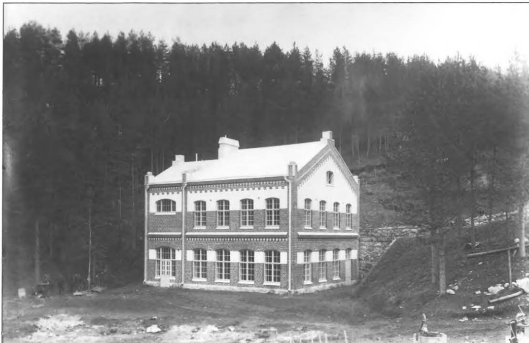
Kuva 5.5. Ahvenistolle vuonna 1910 rakennettu vesilaitos, jonka edessä oikealla näkyy ensimmäinen vedenotto-kaivo. (HKHM)
