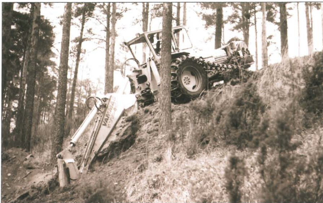
Kuva 7.5. Ahvenistolla maasto-olosuhteet olivat haasteelliset sairaalan vesilinjan rakentajille vuonna 1976. Jyrkässä rinteessä urakoitsija Arvi Ojalan traktori kiinnitettiin ketteillä puustoon. (Tie E.)
