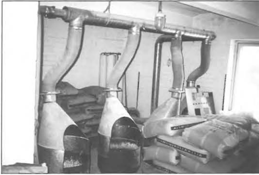
Kuva 9.8. Katuman pintavesilaitoksen yläkerta. Kuvan säikeissä oli alumiinisulfaattia. (VL)
