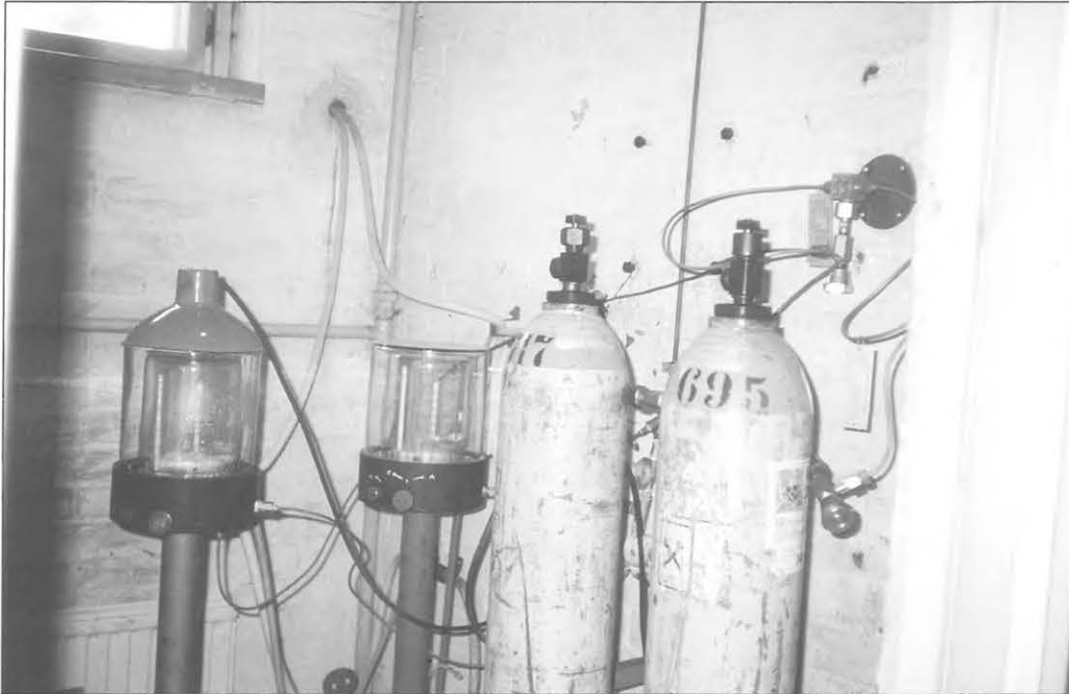
Kuva 9.9. Katuman pintavesilaitoksella käytettävä kloori tuli laitokselle pulloissa. Käytettävät pullot olivat vaa'alla, jolloin käytetyn kloorin määrää voitiin valvoa. (VL)
