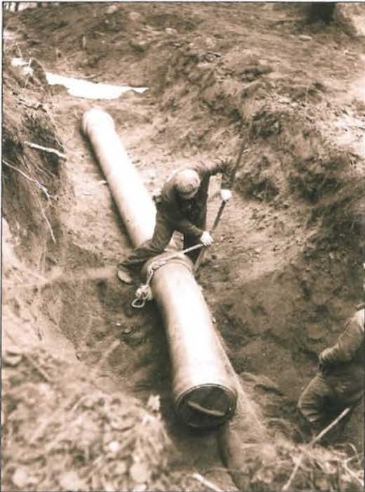
Kuva 7.4. Esko Tie rakentamassa sairaalan linjaa vuonna 1976. Käsittelyssä on 400 mm:n PVC-muoviputki ja alla näkyy 350 mm:n raakavesijohto. (Tie E.)
