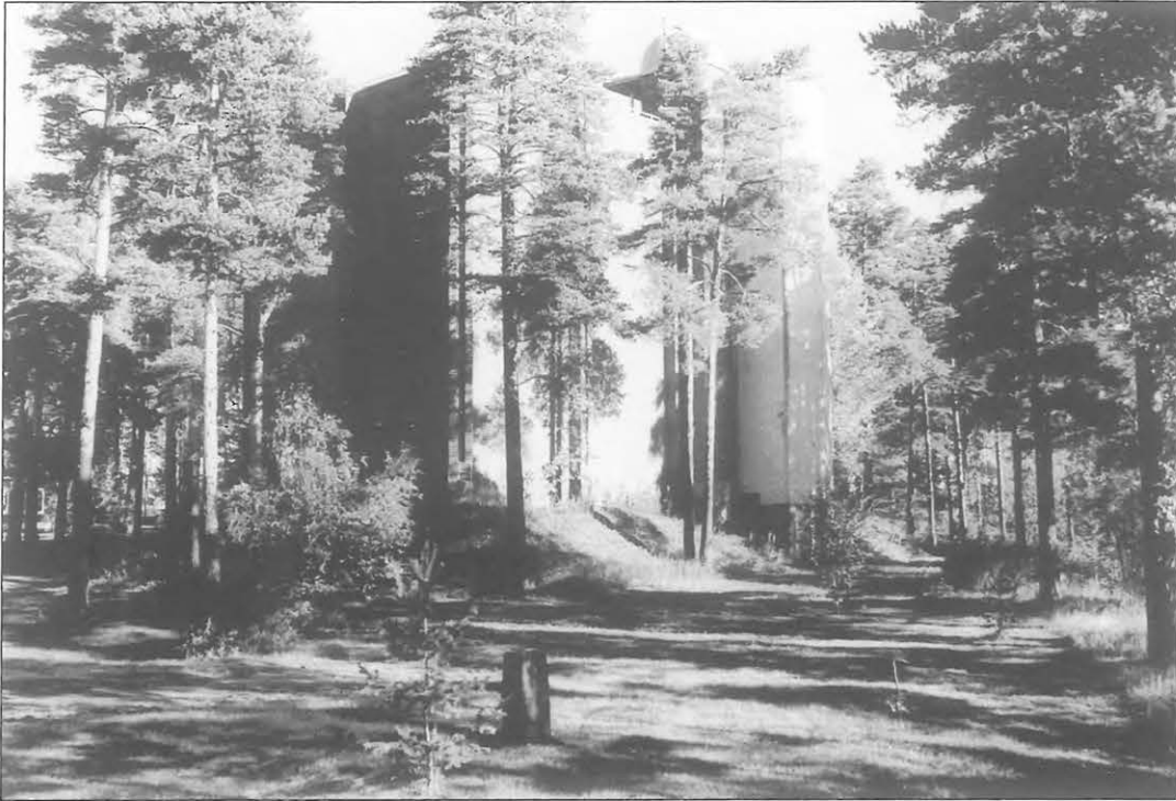
Kuva 8.3. Vuonna 1951 valmistunut vesitorni, jonka tiloissa vesi myös ilmastettiin, selkeytettiin ja suodatettiin. Hiekkasuodattimista vesi valui varsinaisiin vesisäiliöihin, joiden yhteistilavuus oli 1000 m 3 . Kuva on otettu vuonna 1999. (VL)
